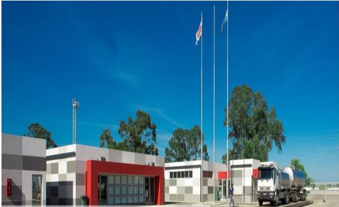
Figura 53: Planta Procesadora De Derivados Lácteos La Ramada Frank Vista Principal
