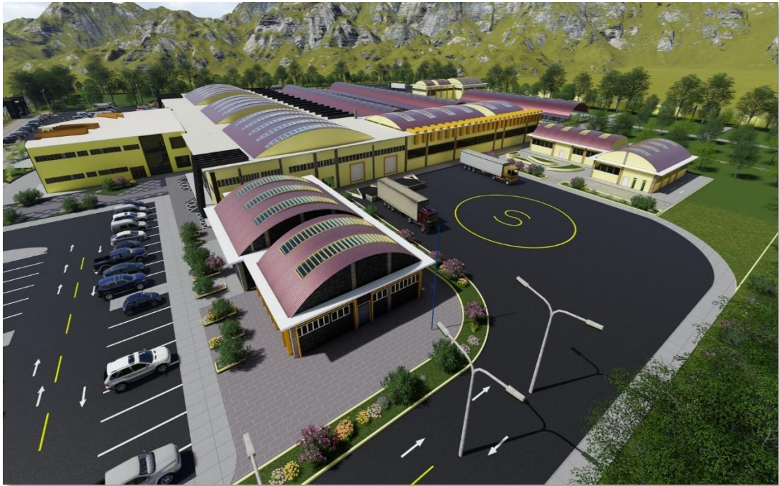
Figura 153: Vista Lateral del área de Servicios
