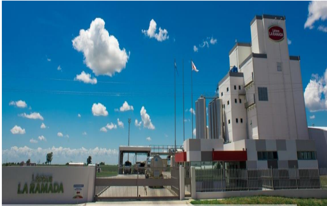
Figura 55: Planta Procesadora de Derivados Lácteos la Ramada Franck vista de Entrada Secundaria
