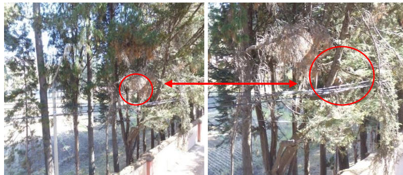
Figura N° 4.18: Árbol en contacto con la red
