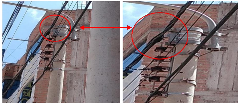
Figura N° 4.17: Porta línea para aisladores tipo carrete
