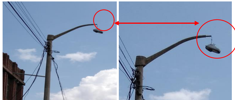
Figura N° 4.15: Luminaria desprendida
