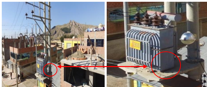
Figura N° 4.11: Media loza con grietas
