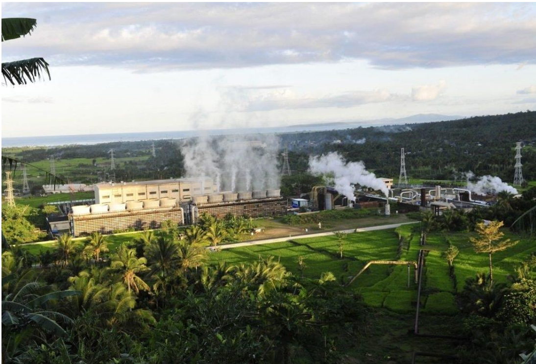
Figura N° 17: Complejo Geotérmico Tiwi. 289 MW. Filipinas
