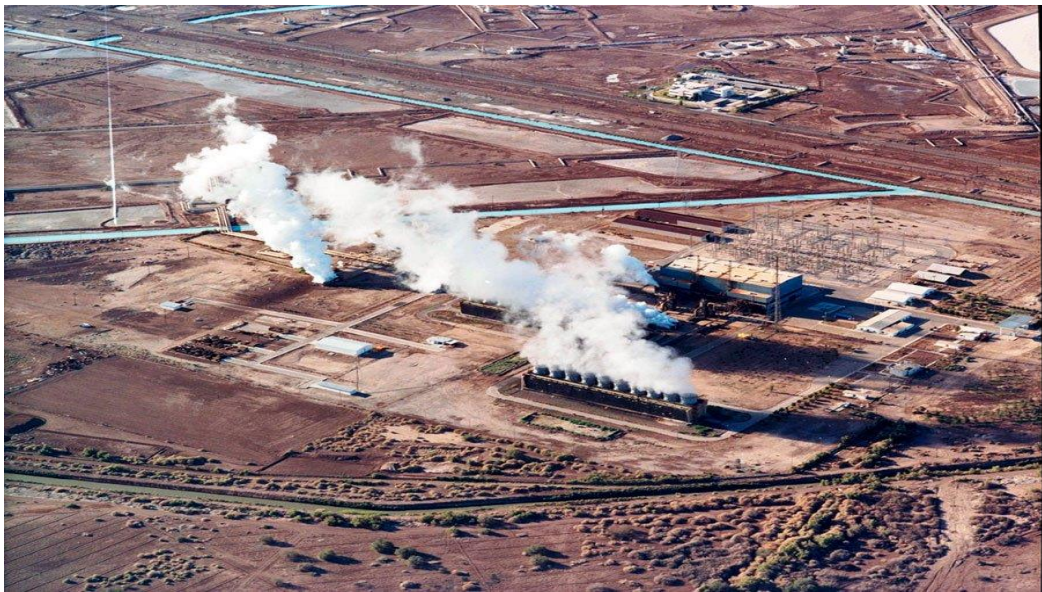
Figura N° 11: Complejo Geotérmico Cerro Prieto. 820 MW. México
