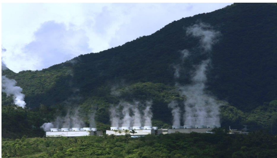
Figura N° 19: Complejo Geotérmico Malitbog. 233 MW. Filipinas
