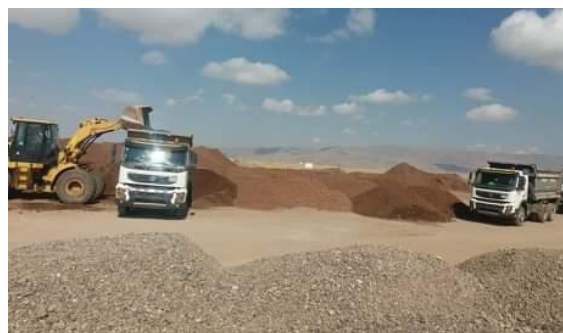
Figura 76: Transporte de material de punto de acopio a tramo de conformación
