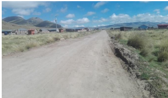
Figura 16: Superficie de la vía no pavimentada
