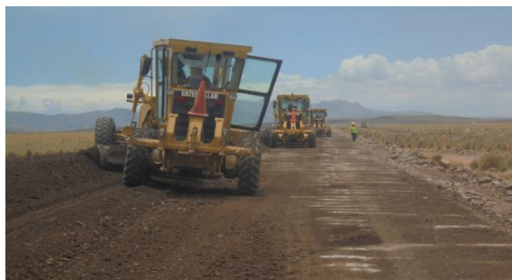
Figura 77: Batido y conformación de base granular
