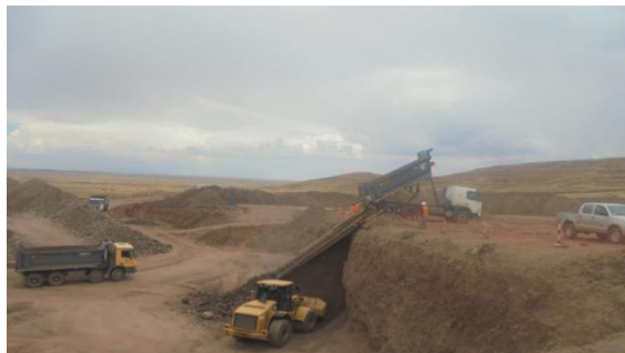
Figura 75: Acopio y zarandeo de material en canteras
