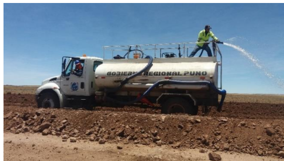
Figura 78: Riego de material para conformación
