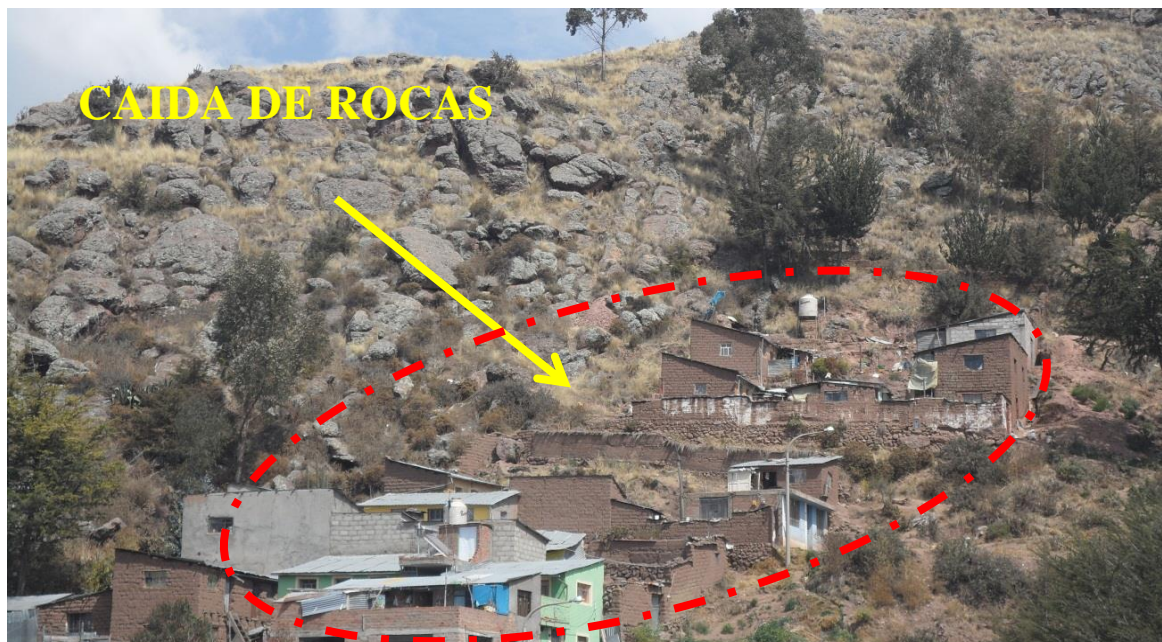
FIGURA N°2: Casas en riesgo caída de roca (Barrio Las Cruces).
