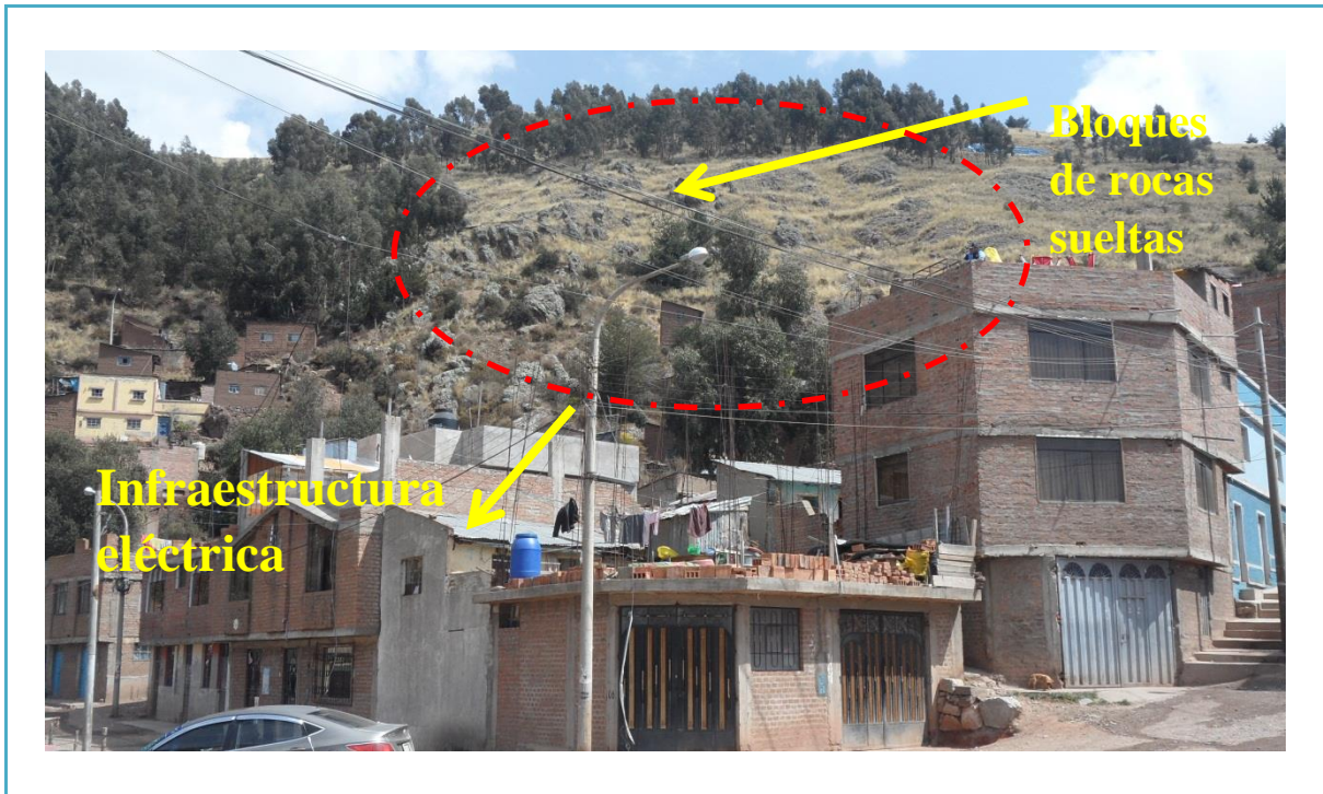
FIGURA N°3: Casas en riesgo caída de roca e infraestructura eléctrica en riesgo (Barrio las Cruces).
