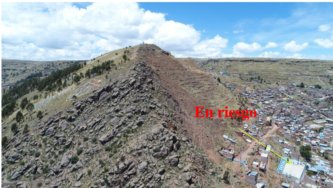
FIGURA N°16: Infraestructura en riesgo (Cancha deportiva Barrio Huáscar).
