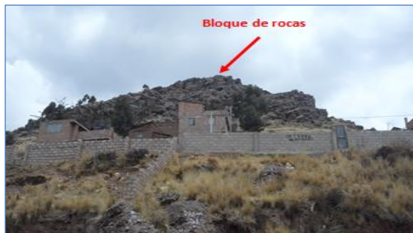
Figura 28: Caída de bloques de rocas. Servicios de edificaciones expuestos.
