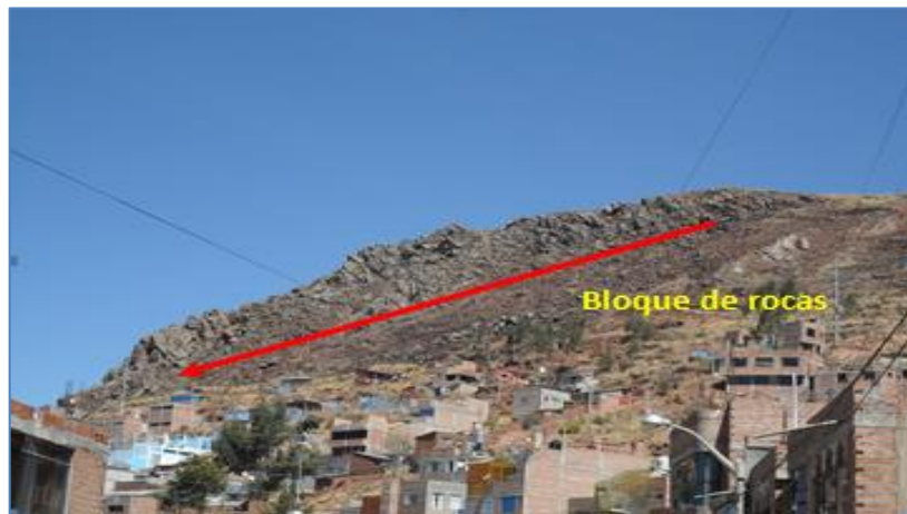
Figura 27: Caída de bloques de rocas. Servicios de edificaciones expuestos.
