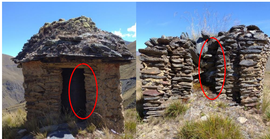
Figura 19. Vanos de acceso de las Chullpas Fuente: la investigadora.
