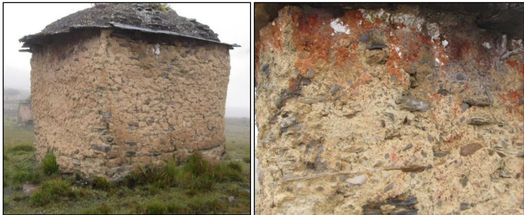
Figura 20. Revoque y pintado de las Chullpas Fuente: la investigadora.
