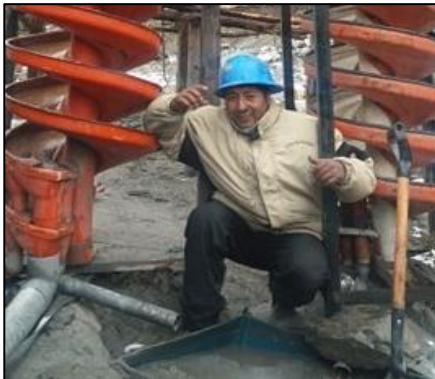
Figura 8. Instalación de equipo espiral gravimétrico
