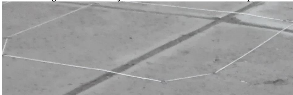
Figura 3.3: Primera forma de instalación del Sensor Loop
