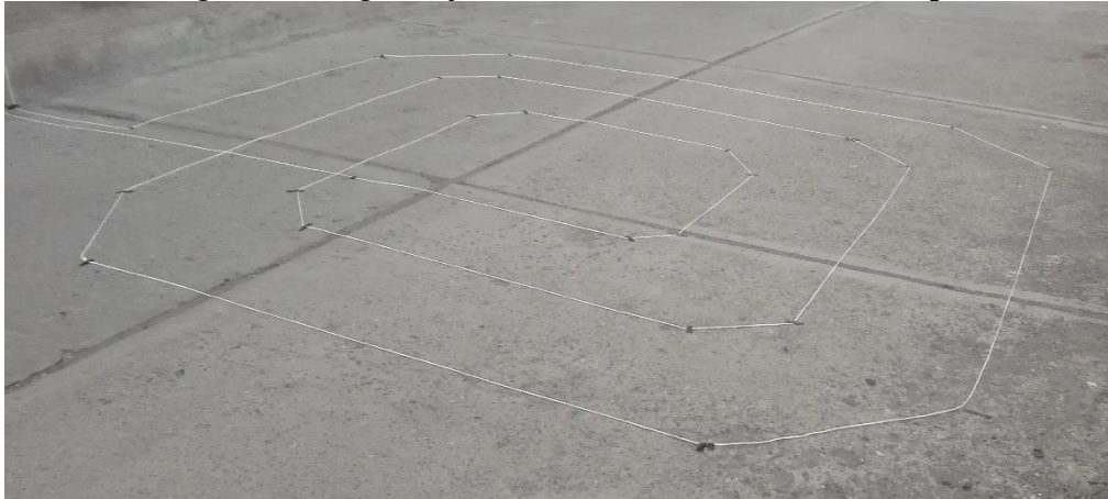
Figura 3.4: Segunda forma de instalación del Sensor Loop
