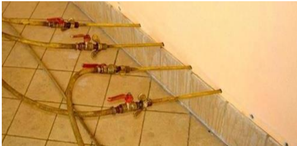
Figura 2.13: Inyección de Polímeros a Muros Fuente: https://reformacoruna.com/humedad-capilaridad-muro/
