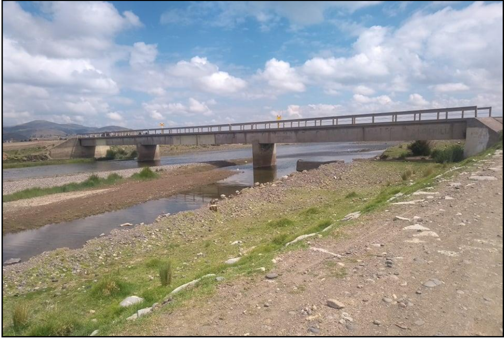
IMAGEN N° 01: En la imagen se observa el puente Cabanillas (12-02-2020)
