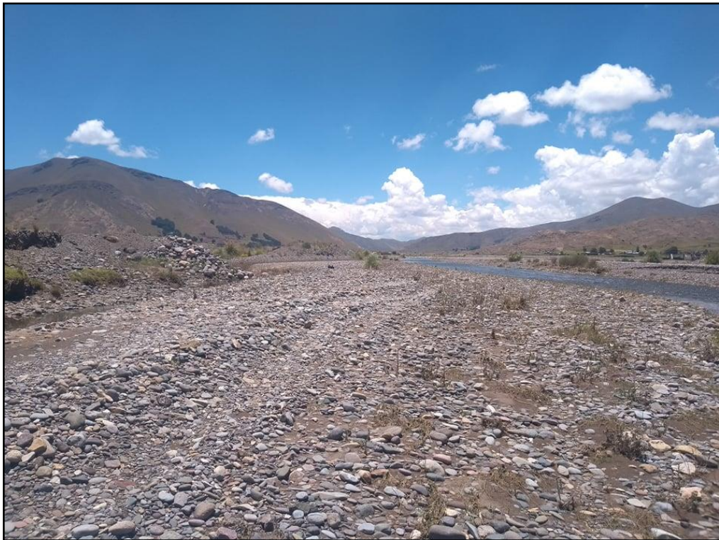
IMAGEN N° 04: En la siguiente imagen se observa la acumulación de sedimentos que son transportados desde aguas arriba en épocas de avenidas. (12-01-2020).
