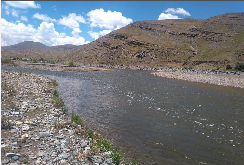
IMAGEN N° 02: En la imagen se observa el flujo de aguas – aguas abajo de la bocatoma Cabanillas (12-01-2020).
