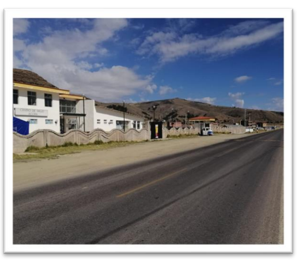
Foto 31: progresiva 1391+500, puesto salud Acora, falta la implementacion de la señal de servicios de emergencias.
