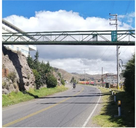
Foto 21: progresiva 1365+544, puente peatonal con altura máxima de 5.8
