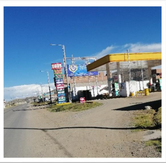
Foto 29: Zona Urbana instalación de grifos.
