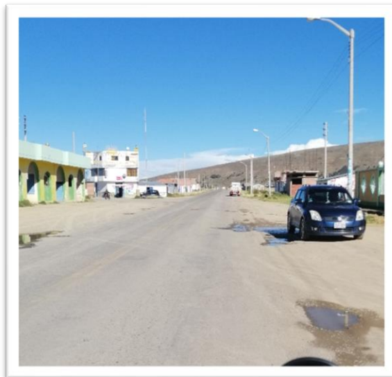
Foto 7: Progresiva 1387+450, las demarcaciones del borde de calzada en ambos sentidos no están visibles.
