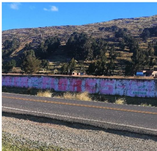
Foto 17: Progresiva 1373+750, berma del tramo muy desgastado en ambos sentidos
