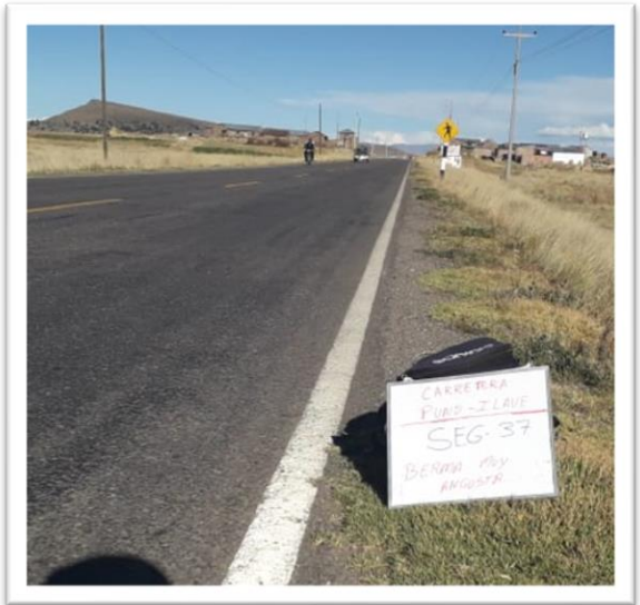
Foto 15: progresivas 1400+450 al 1401+300, muchos tramos de la vía presentan Bermas angostas y con presencia de vegetación.
