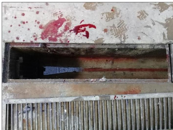
Figura 28. Canaleta de evacuación de las aguas residuales
