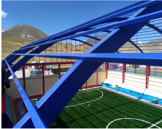
Figura 16. Estructura metálica evaluada
