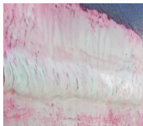
INSPECCION DE LA SOLDADURA
