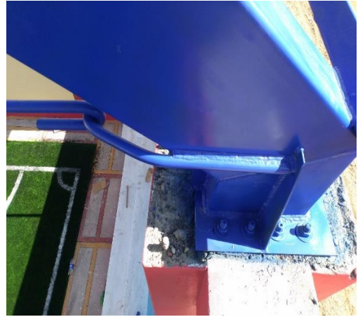
Figura 17. Junta soldada evaluada
