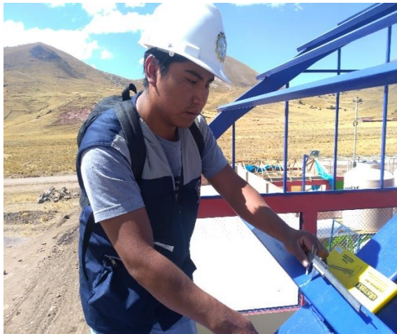
Figura 18. Midiendo el cordón de soldadura
