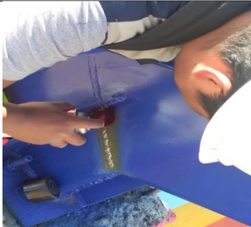
APLICACIÓN DEL PENETRANTE
