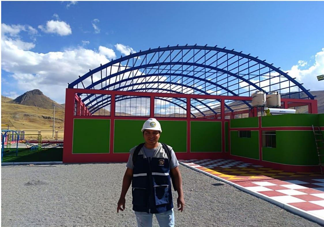
Figura 15. Estructura metálica de Huacullani
