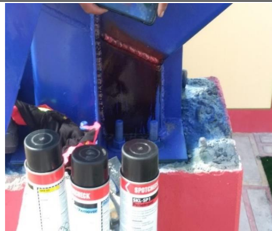
LIQUIDO PENETRANTE APLICADO
