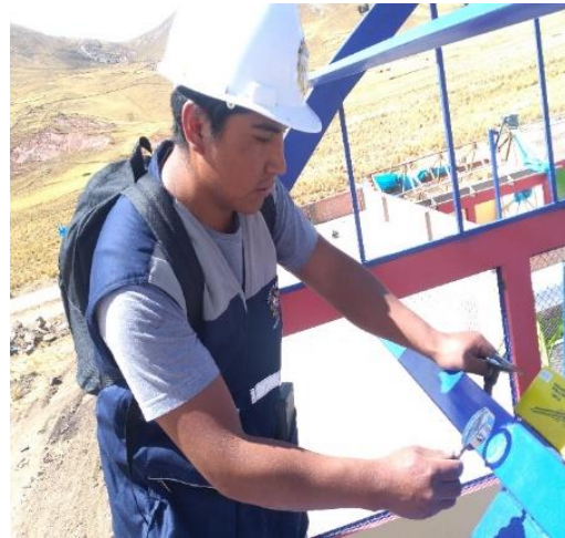
Figura 19. Inspección de cordón de soldadura
