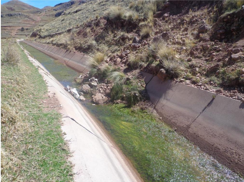
Foto 03: Derrumbe de Talud Adyacente del Canal, y se observa el poco interés de realizar mantenimiento por el no uso del mismo.
