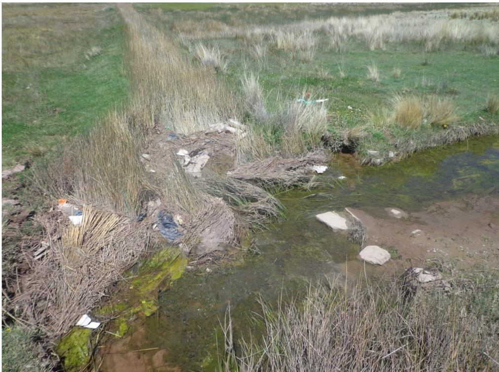
Foto 12: En la foto se puede apreciar colmatación de residuos sólidos en el canal lateral de irrigación Azángaro etapa II.
