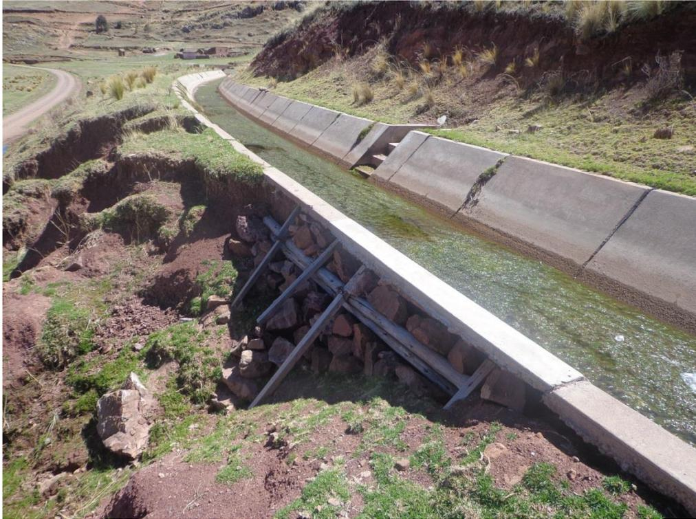
Foto 05: En la foto se puede observar erosión de talud base lateral producida por desborde y filtración de agua del canal. .
