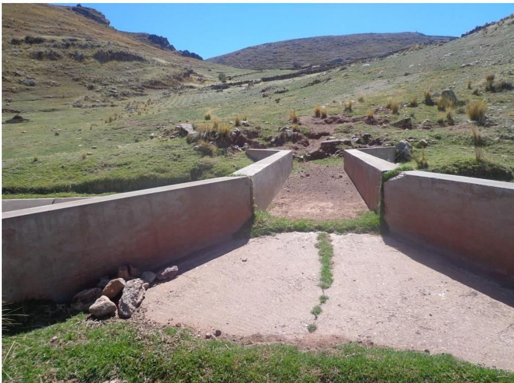
Foto 06: En la foto se puede observar obra de arte (balsa) del canal, a simple vista uno puede apreciar que no existe encauzamiento de agua. .
