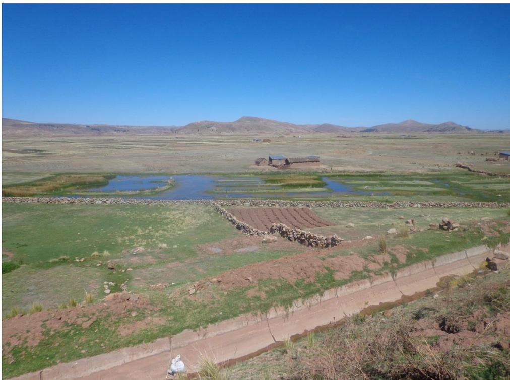
Foto 04: En la foto se puede apreciar aniegos ocasionados por la excesiva filtración de agua de los canales (no existían anteriormente según poblac)
