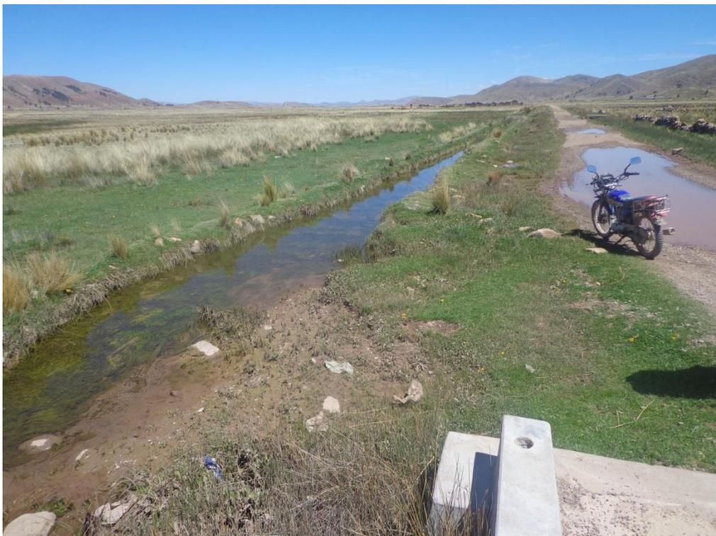
Foto 10: En la foto se puede apreciar la falta de canales laterales el cual muestra el mal uso del recurso hídrico en el canal de irrigación Azángaro etapa II. .
