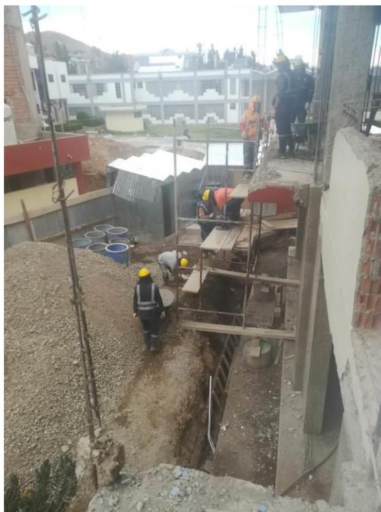
Vaciado de concreto en columnas encamisadas y placas A-3 y A-4 del Sector 1 en el Segundo Nivel.
