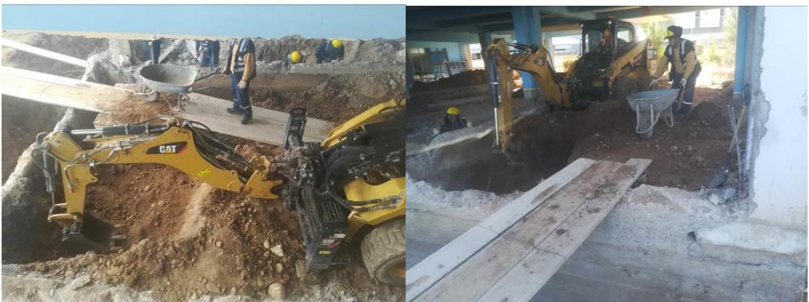
Excavación de zanjas con equipo Bob Cat en Sector 4 y Sector 5.
