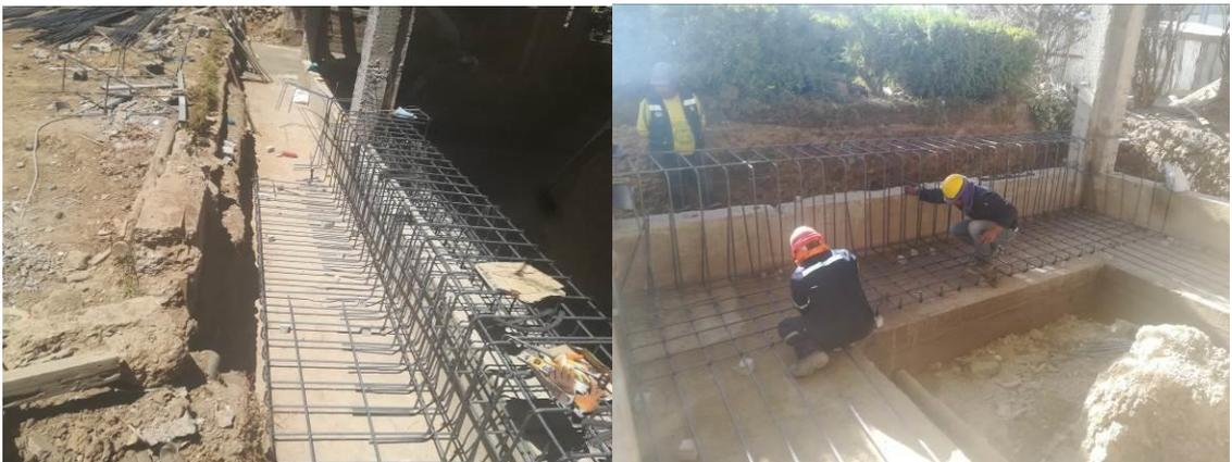
Habilitación de acero longitudinal y transversal para Losa de Cimentación.
