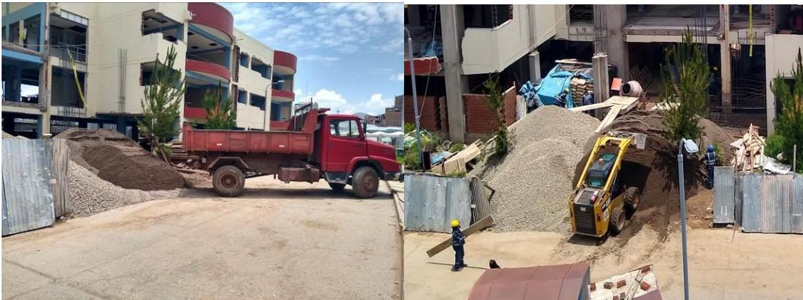
Descarga y distribución de agregados para la producción de concreto.
