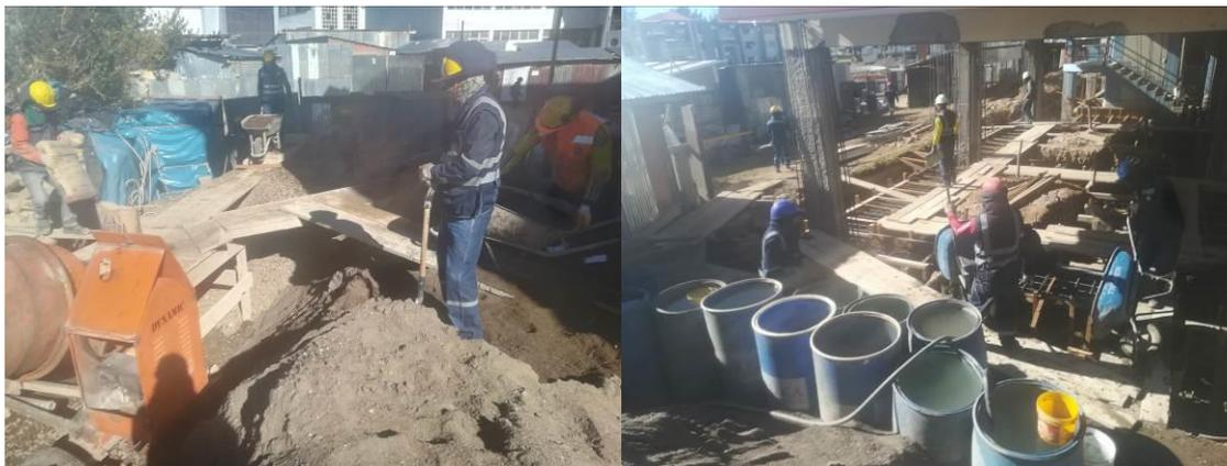
Preparación de insumos para la producción de concreto para Losa de Cimentación.
