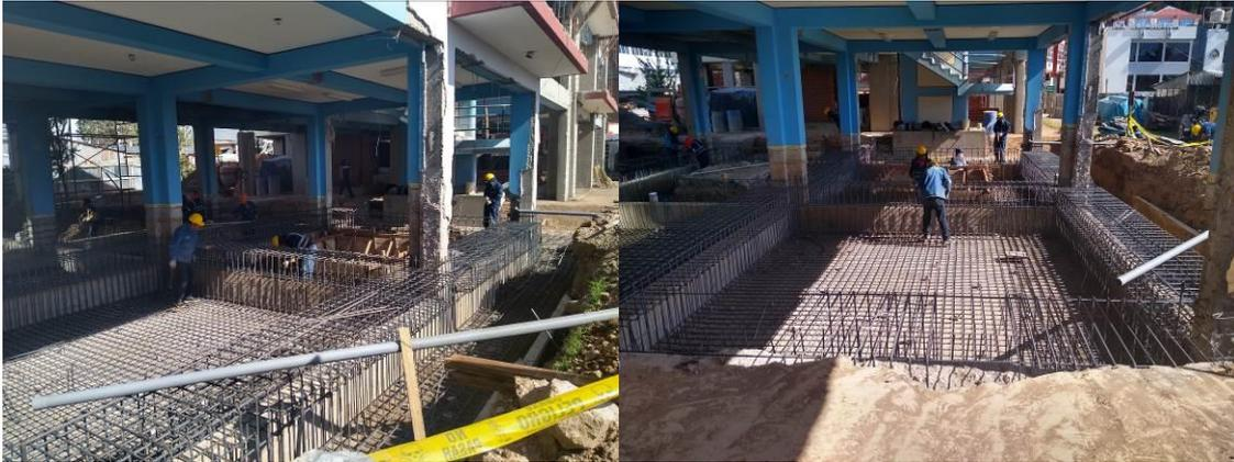
Habilitación de acero longitudinal y transversal sobre vigas de cimentación existentes para Losa de Cimentación y columnas encamisadas del Sector 4 y Sector 5.
