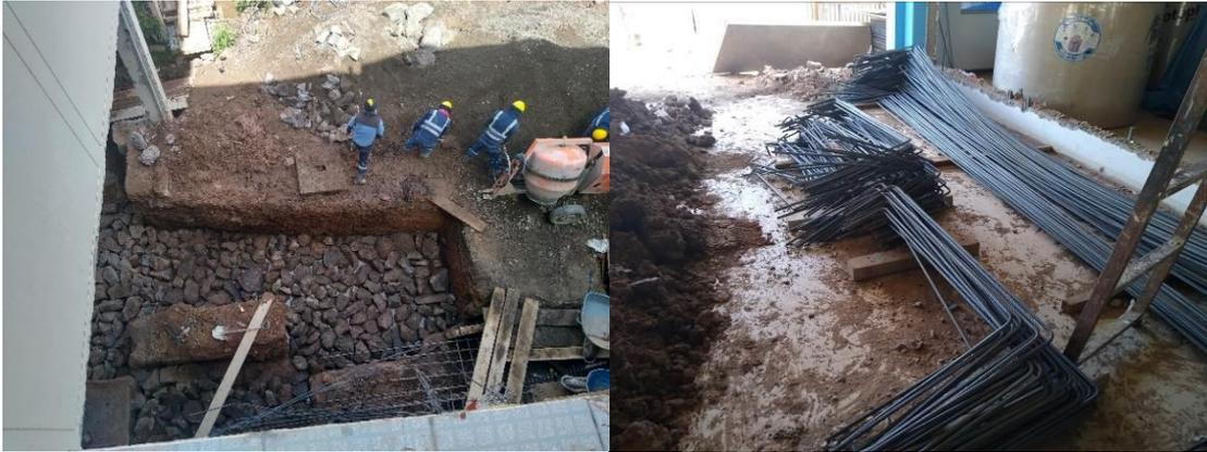
Enrocado y preparación de acero para Losa de Cimentación entre los ejes 1 y 2 del Sector 4.
