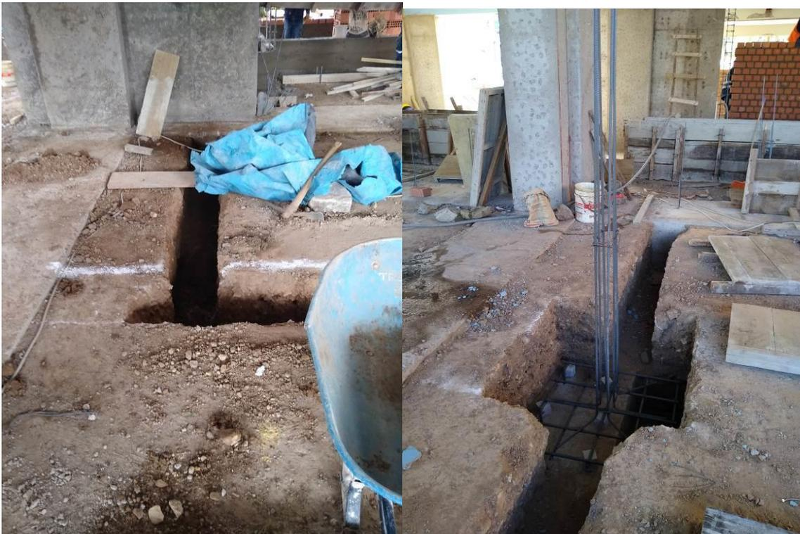
Excavación de zanjas para cemento corrido en el Sector 2
