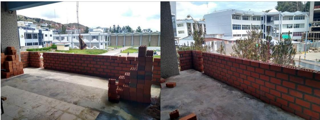
Levantamiento de muros del ladrillo KK del Sector 2 en el Segundo nivel.
