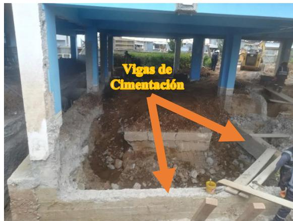
Nota: En la figura 61 se observa la existencia de vigas de cimentación en el eje 4-4 entre los ejes E y F que conectan las zapatas de ambas columnas. “Elaborado por el equipo de trabajo”.
