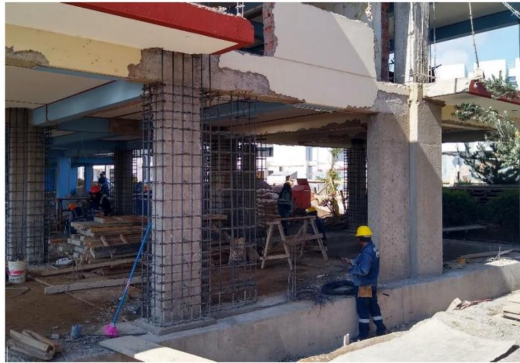
Nota: En la figura 67 se muestra la habilitación del acero en el encamisado de la columna y placa A-2, sin embargo, la estructura de concreto inicia desde el N.L.C. +0.00m mas no en -0.50m como estaba estipulado anteriormente. “Elaborado por el equipo de trabajo”
