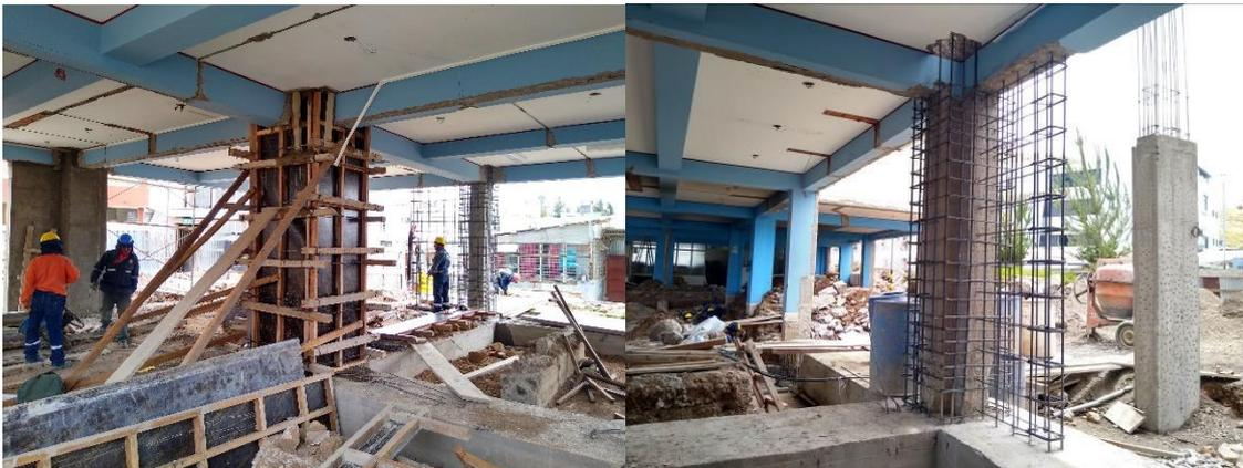
Encofrado y habilitación de columnas y placas del Sector 2 en el primer nivel.
