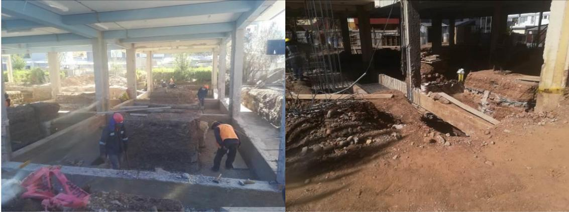
Excavación de zanjas para Losa de Cimentación en Sector 1, Sector 2 y Sector 3.
