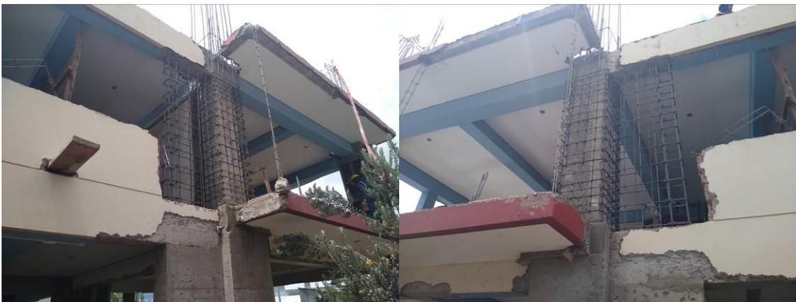
Habilitación de acero para encamisado de columnas y placas verticales adyacentes A-2 y A-3 del Sector 1 en el Segundo nivel.
