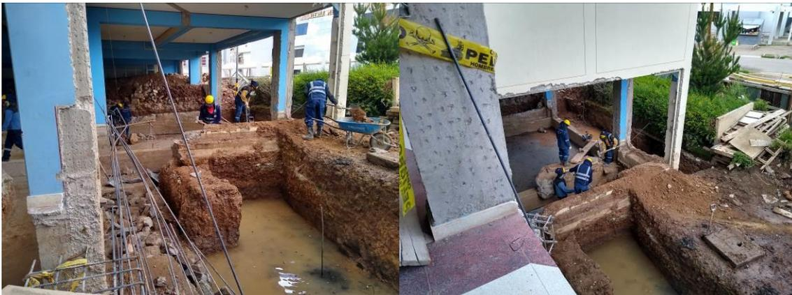
Excavación de zanjas para enrocado entre los ejes 1 y 2 del Sector 4.
