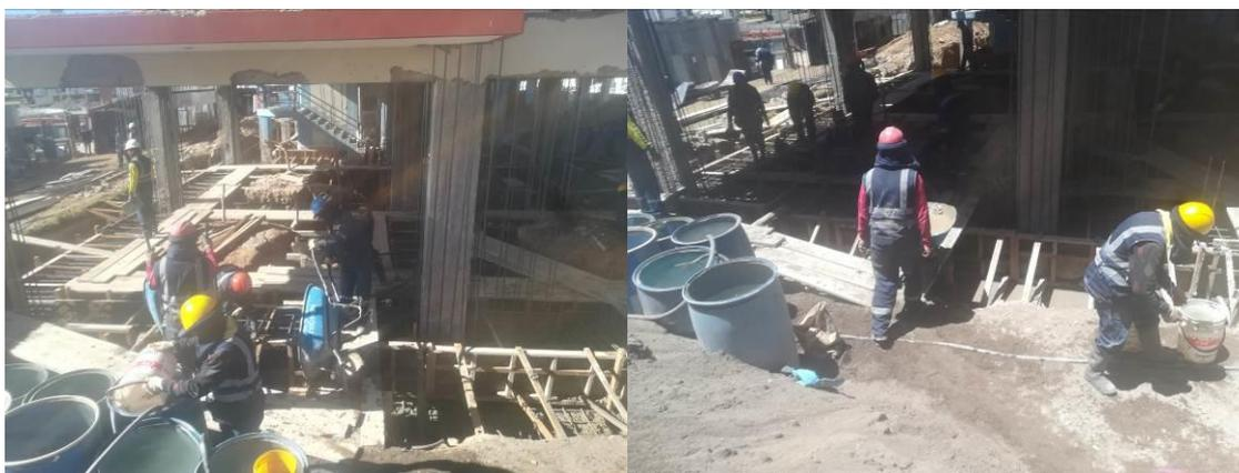
Vaciado de concreto en Losa de Cimentación de Sector 1, Sector 2 y Sector 3
