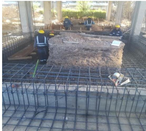
Nota: En la figura 66 se muestra el reforzamiento de acero longitudinal y transversal para la losa de cimentación el cual pasa por encima de las vigas de cimentación para el reforzamiento estructural. “Elaborado por el equipo de trabajo”
