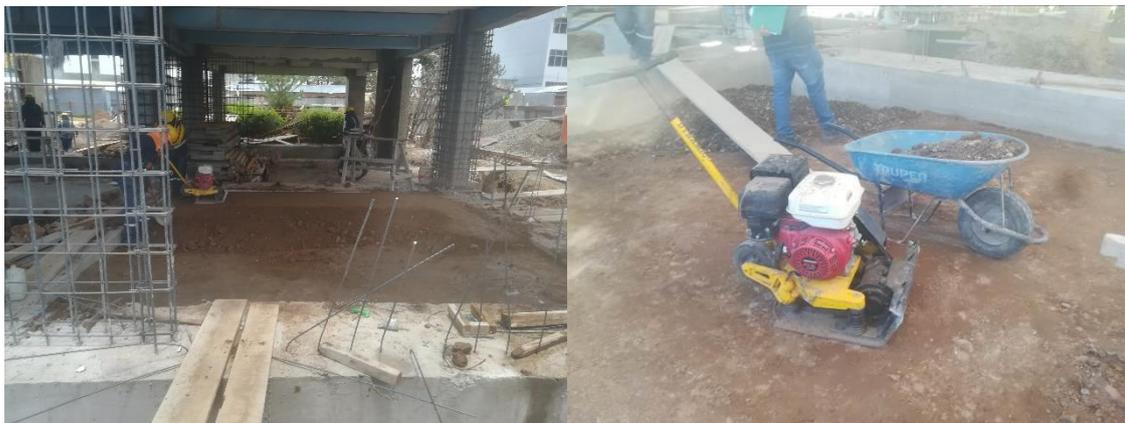
Relleno con material propio y apisonado con plancha compactadora en Sector 1.
