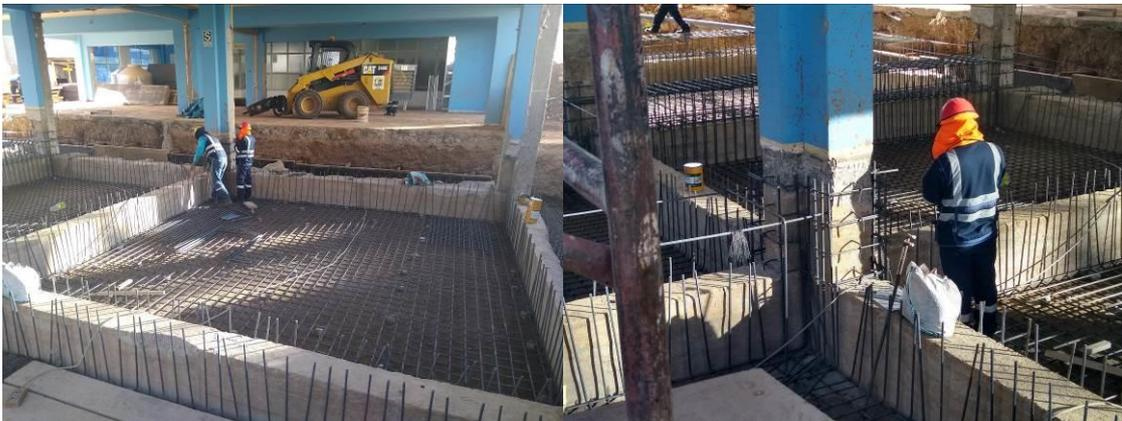
Habilitación de acero longitudinal y transversal en Losa de Cimentación y columnas encamisadas del Sector 4 y Sector 5.
