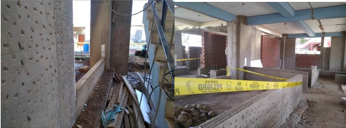
Concreto en sobrecimientos y liberación para asentamiento de muros de ladrillo KK.
