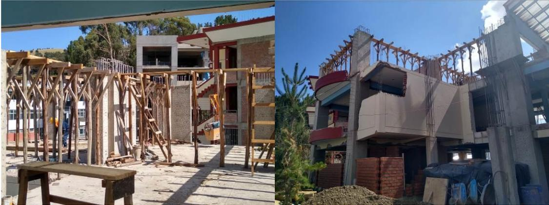
Encofrado de vigas horizontales del Sector 1 y Sector 2 en el Tercer nivel.
