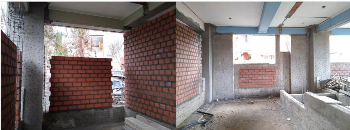
Levantamiento de muros de ladrillo KK en Sector 1.
