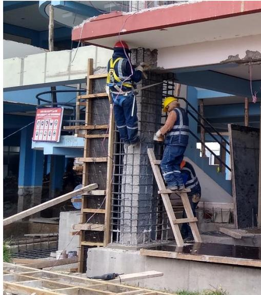
Nota: En la figura 83 se puede observar el encofrado de la placa PL-10 en el Primer nivel cuya base se considera desde la parte superior de la Losa de Cimentación. “Elaborado por el equipo de trabajo”.
