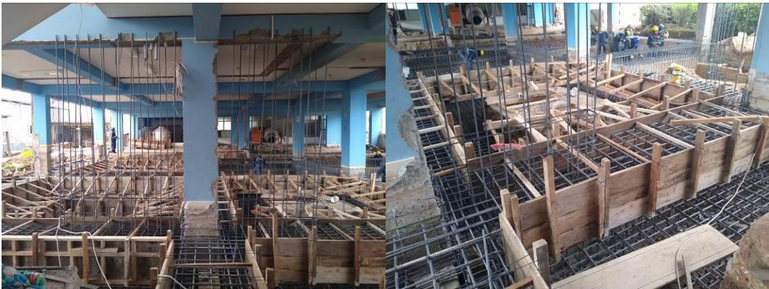
Encofrado de Losa de Cimentación y columnas encamisadas del Sector 4 y Sector 5.
