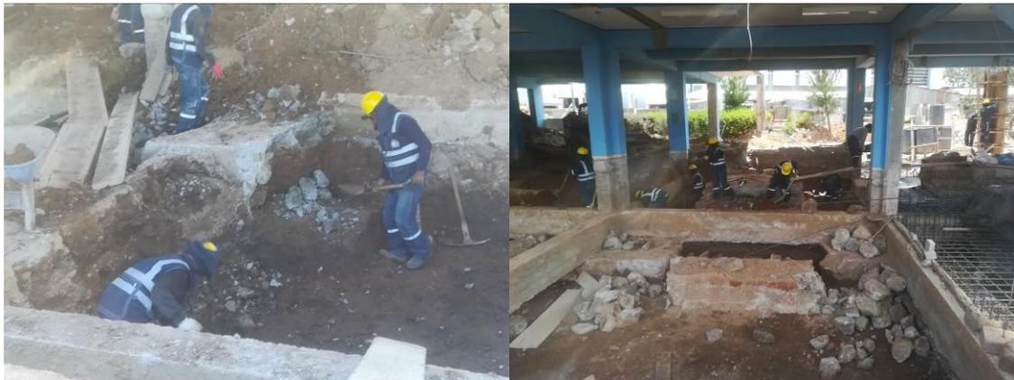
Excavación de zanjas y demolición de piso para Enrocado del Sector 4 y Sector 5.
