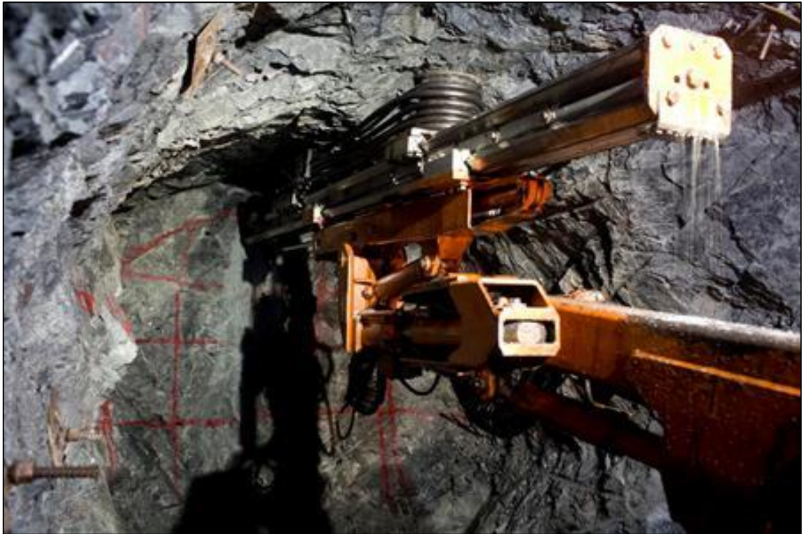
Figura 7. Perforación de taladros largos en el proyecto del Pique Principal.
