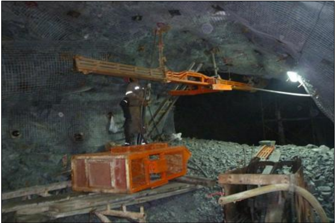
Figura 6. Construcción del Pique circular en la Unidad Minera San Andrés.
