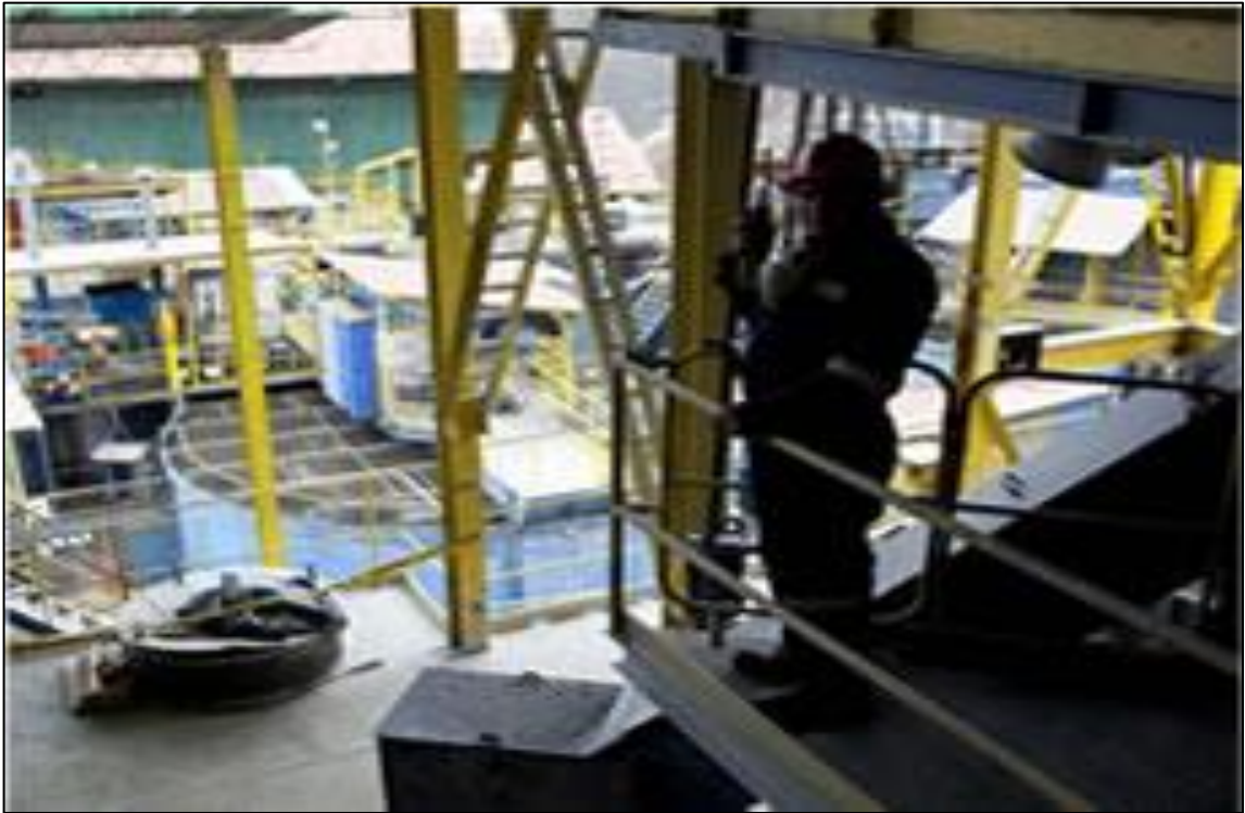
Figura 5. Instalaciones de la Planta Concentradora San Andrés.
