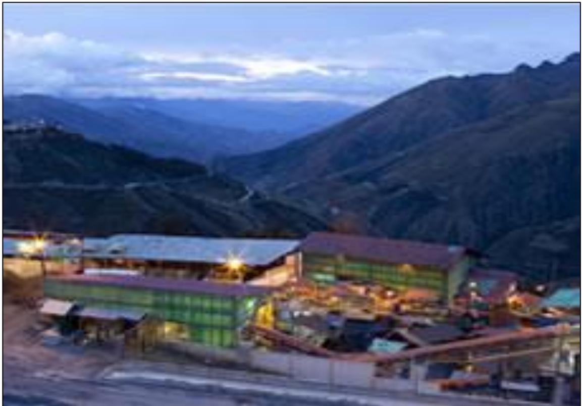
Figura 4. Planta concentradora San Andrés, ubicada aprox. a 4100 m.s.n.m.
