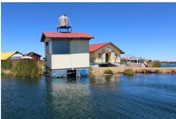
Figura 33. Islas Uros, Colegio Adventista los Uros, ausencia de totora en confección de ambientes, se reemplaza con material prefabricado. Fuente: Goyzueta (2019).
