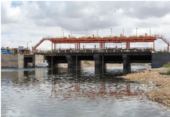
Figura 23. Compuerta de regulación río Desaguadero, abierta permanentemente desde 2008, produce el descenso del nivel de agua del lago Titicaca, alterando hábitats y la biodiversidad. Fuente: Goyzueta (2019).
