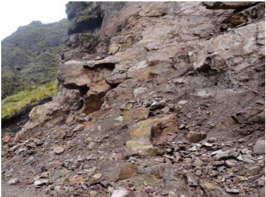
Foto 6. Vista de afloramiento de macizo rocoso, Km. 3+350, donde se observa roca intemperizada y la orientación del buzamiento de las discontinuidades desfavorables
