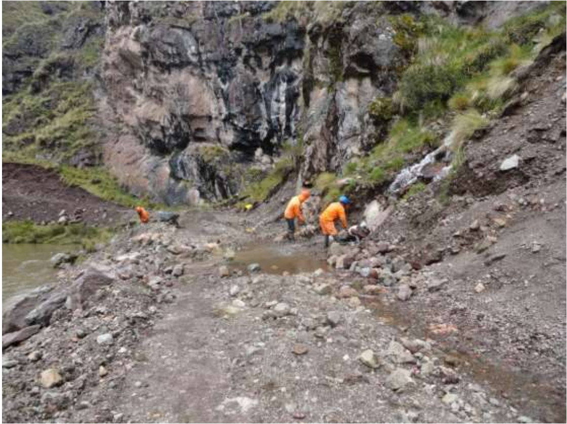
Foto 7. Extrayendo muestra del talud en suelos, Km. 2+750, para la prueba en laboratorio
