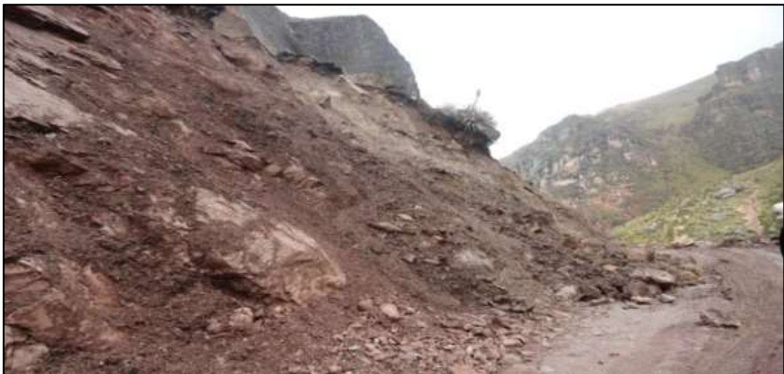
Figura 13. Deslizamiento del suelo al estar conformada en su estructura deleznable de arena arcillosa con contenidos de limo, saturados, progresivas del 2+700 al 2+900
