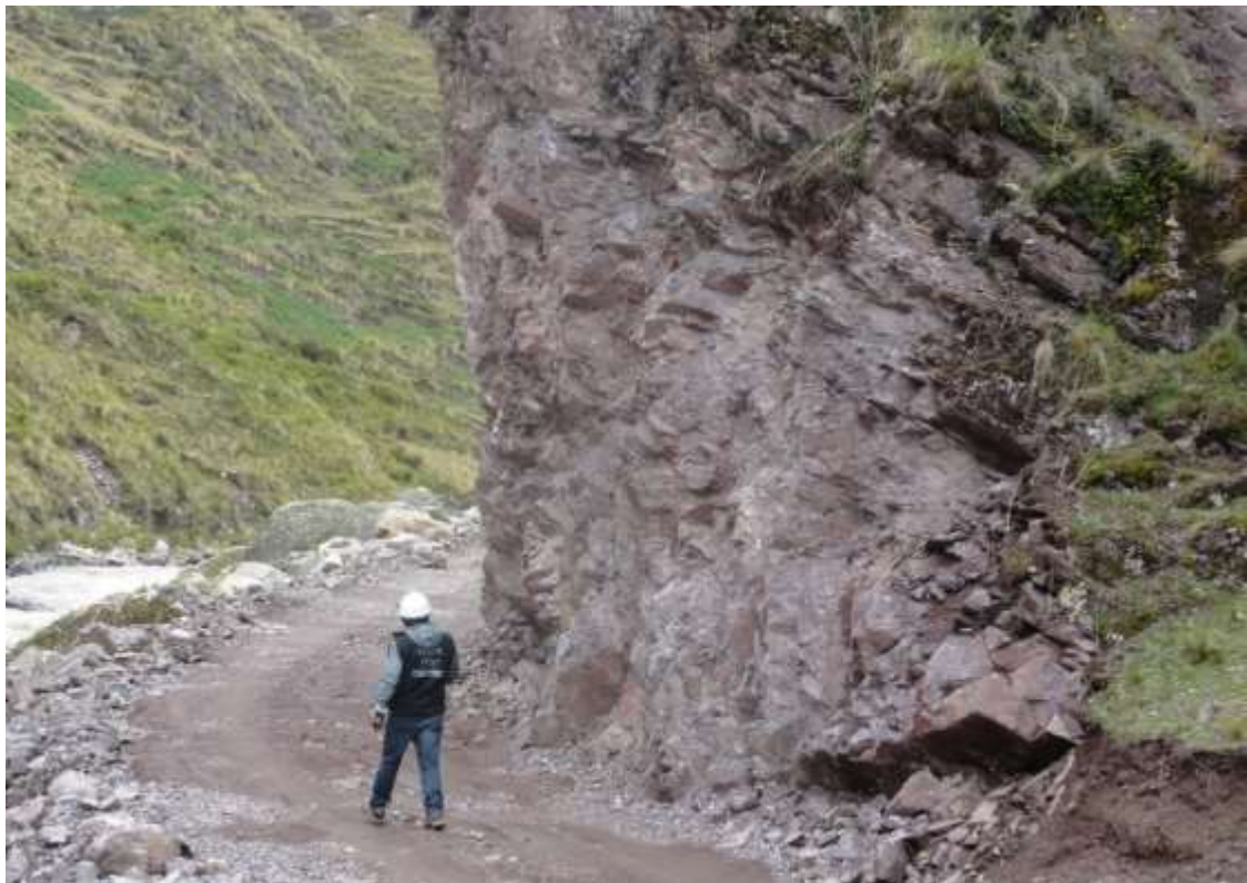
Foto 4. Corte de Talud en roca en la progresiva Km. 3+250
