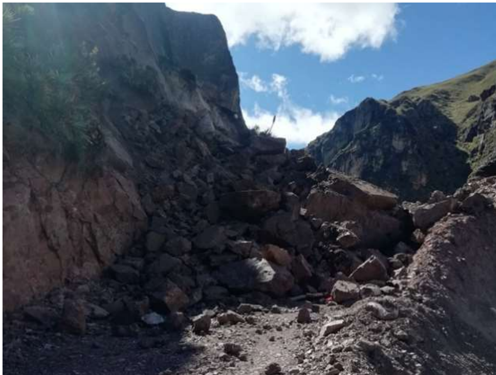
Figura 11. Progresiva. 2+510 deslizamiento del cuerpo de talud
