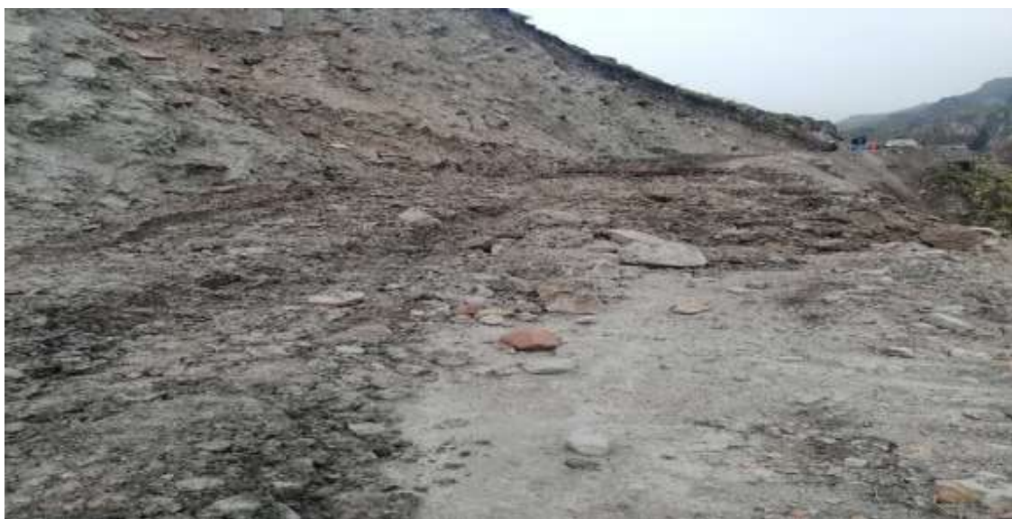
Figura 17. Estructuras de taludes conformadas por suelos orgánicos y fragmentos de roca, progresivas del 3+870 al 4+200
