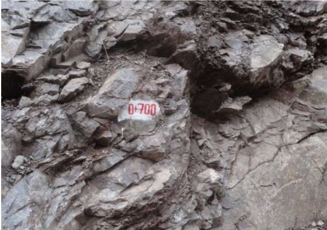
Foto 3. Vista del macizo rocoso en condiciones inestables, Km. 0+700, debido a la alta presencia de discontinuidades
