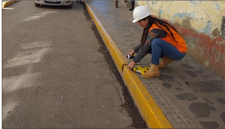
Figura 15. Segmentación de unidades de inspección (franjas)
