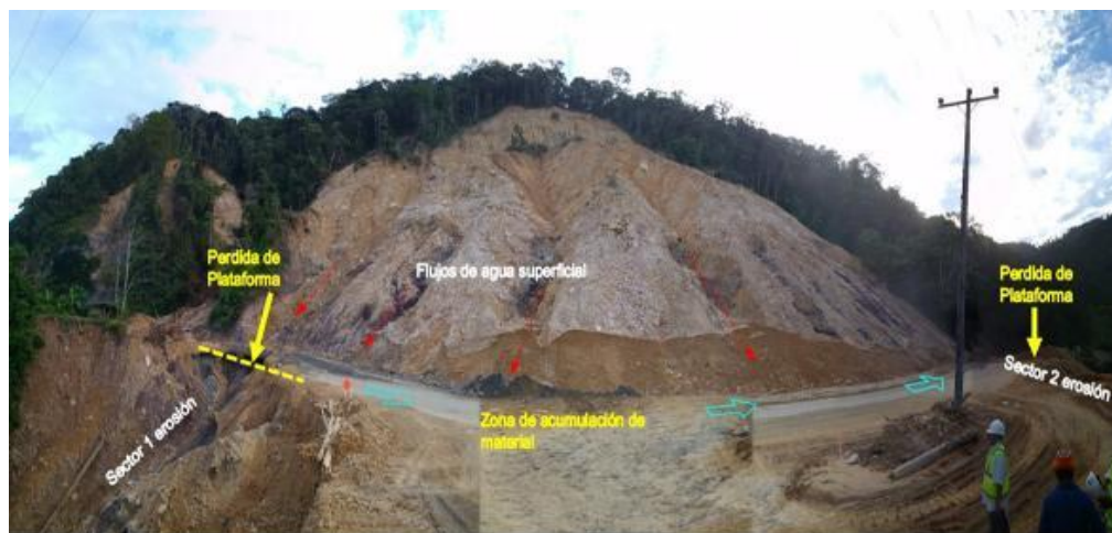
Figura N°24: Perdida de plataforma del borde derecho en dos sectores por la erosión que ha formado surcos profundos.
