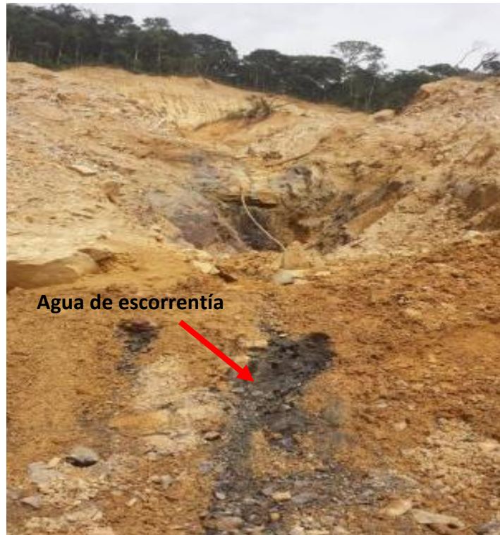
Figura N° 23: Se observa escorrentía del agua de precipitación.
