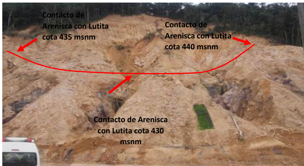
Figura N° 22: Grupo Huayabamba, contacto de areniscas cuarzosas feldespáticas de color marrón claro (suprayacentes) con la Lutitas rojas a marrón (infrayacentes), el macizo se encuentra levemente plegado en estructura sinclinal.
