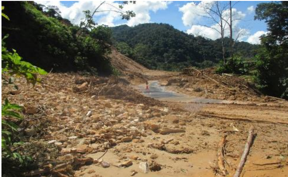
Figura N° 26: Material detrítico producto del deslizamiento en masa sobre la plataforma.
