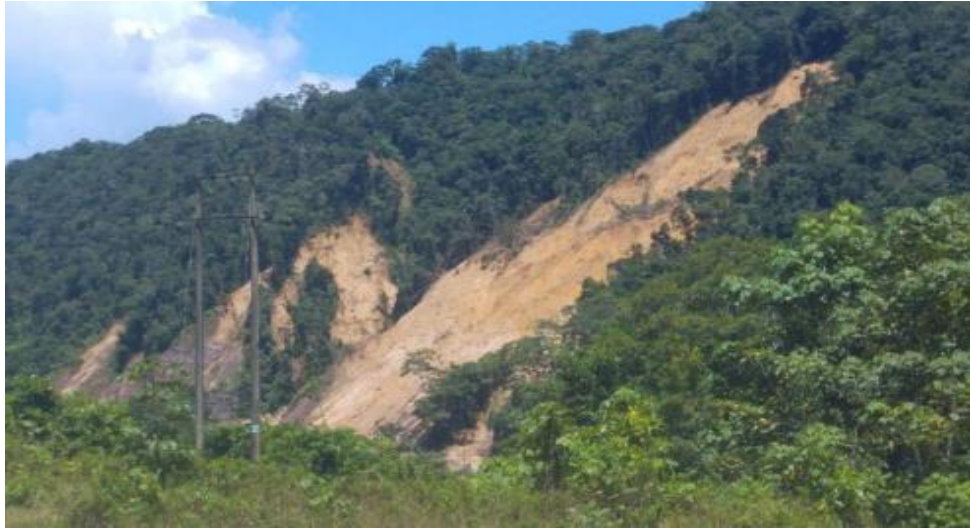
Figura N° 25: Vista panorámica, se aprecia erosión e inestabilidad en los taludes sub tramo Km. 344+000 - km. 344+540.
