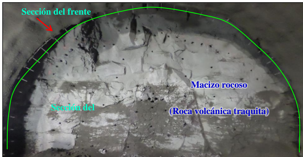
Figura 25 Afloramiento de roca volcánica traquita en frente del túnel CV-203 progresiva: 7+502.30 a 7+504.70. Fuente: Elaboración de autor
