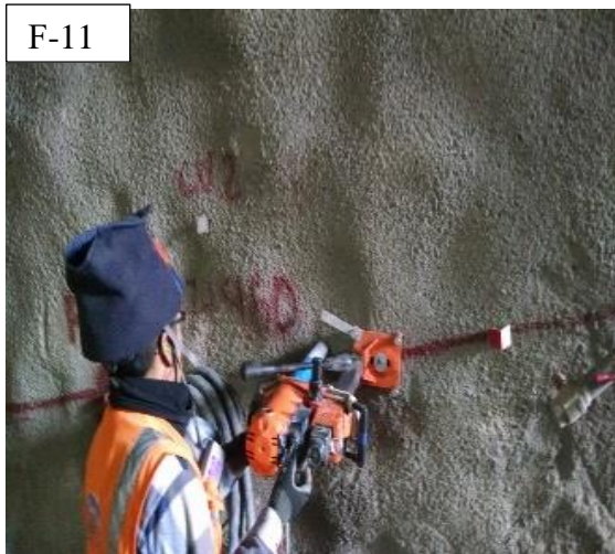
Figura M-11. Extracción de núcleo para km 7+460.00
