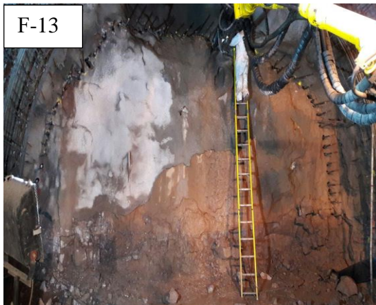
Figura F-13. Perforación de SpillinnBars con perno autopercutores R-38
