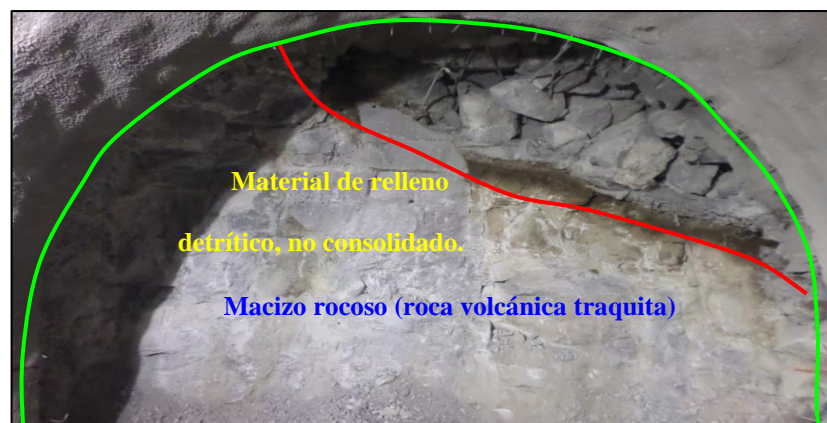
Figura 24 Excavación de Relleno detritico y macizo rocoso, progresivas: 7+488.30 a 7+490.10. Fuente: Elaboración del autor.
