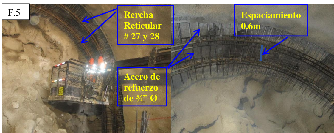
Figura F.5: Instalación de cercha reticular de 04 barras
