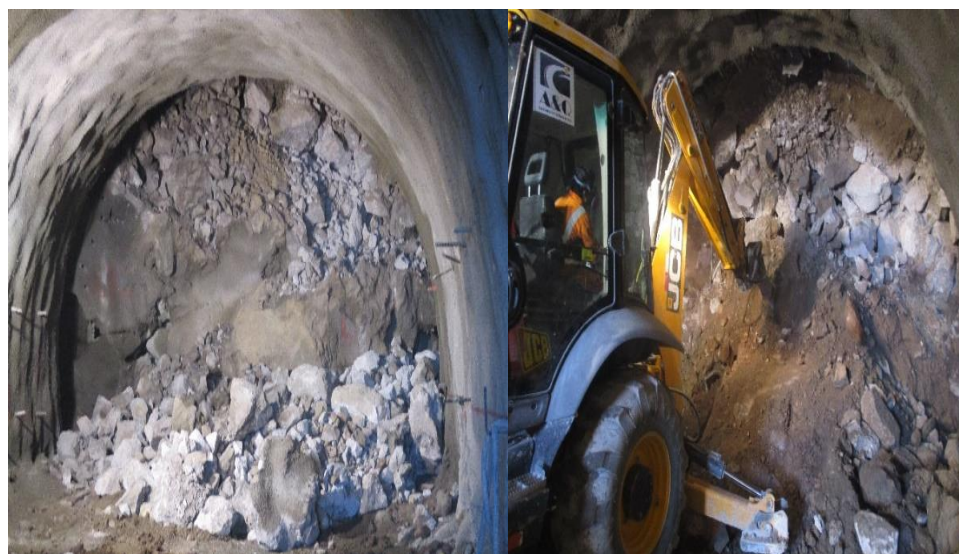
Figura 26 Excavación en relleno detritico, progresivas: 7+529.70 a 7+531.00. Fuente: Elaboración del autor.
