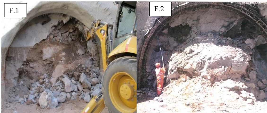
Figura F-1. Excavación de túnel cv-203 en relleno detrítico y bloques de Traquita Figura F-2. Instalación de cercha reticular de 4 barras km 7+441.00
