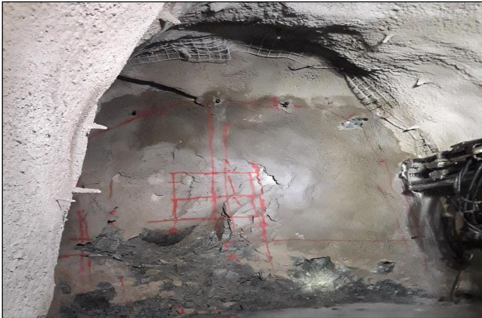
Figura N.º55: *Pintado inadecuado de malla de perforación de la GAL 9110-S*
