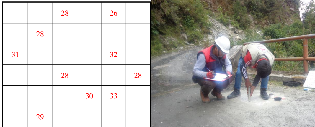
Figura 15: Nro de golpes registrado en losa del Puente Tiraca - Phara.
