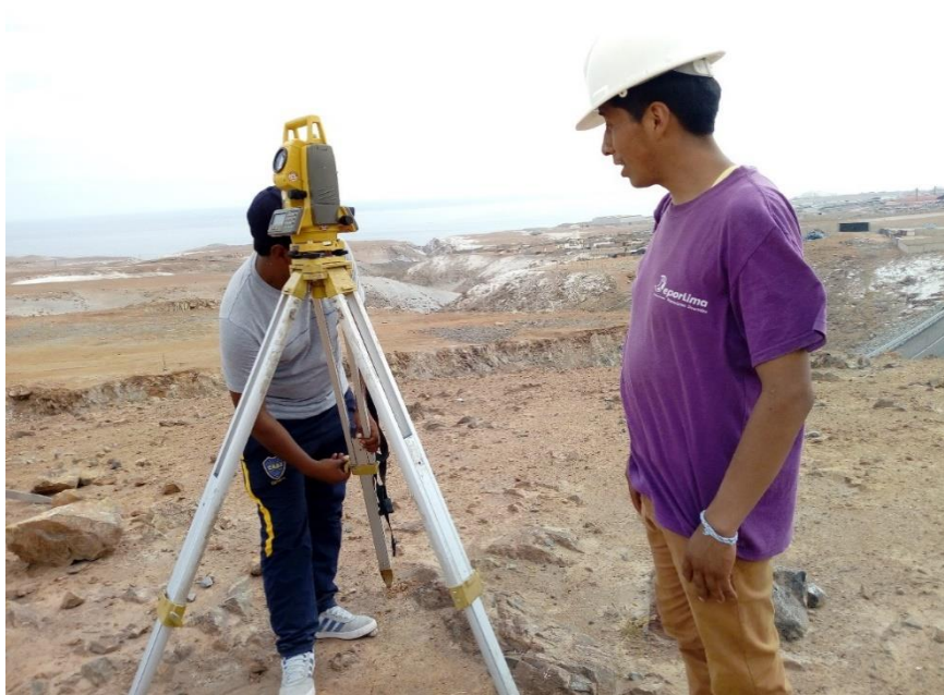
Foto 10: Verificando el equipo de estacion total despues de realizar puntos de cambio
