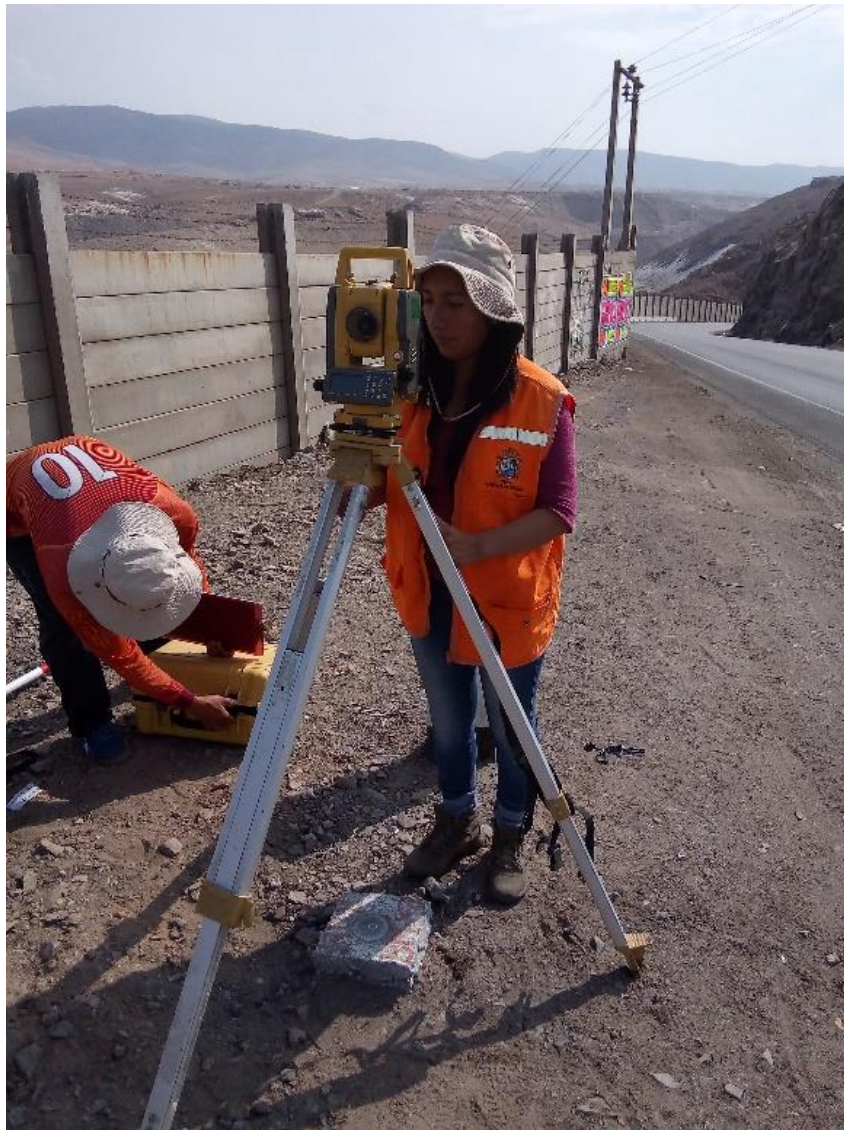
Figura 19. Estación de equipo en BM – MP – 02, Matarani.
