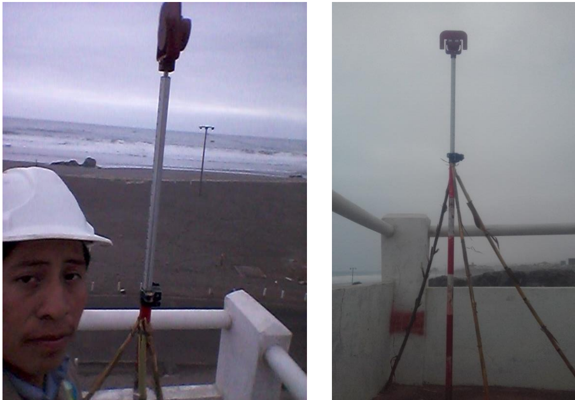
Figura 20. Montaje y presentado de prisma nivelacion trigonométrica.
