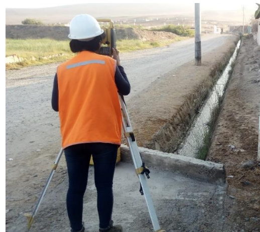
Foto 08: Realizando la nivelacion trigonometrica con estación total tramo Mejia – la Curva
