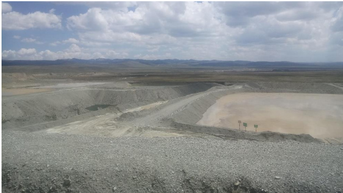
Imagen 3. Pozas de sedimentación
