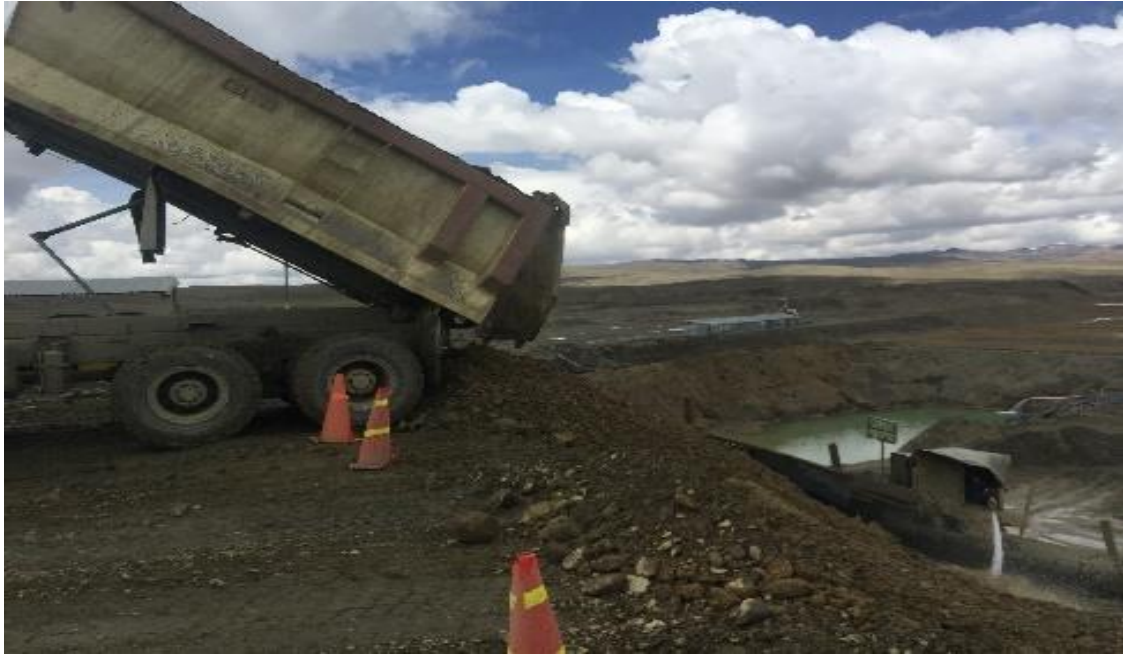
Figura 7. Tolva de alimentación y lavado
