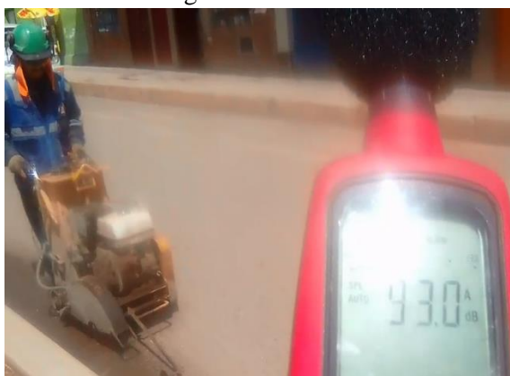
Figura 70: Monitoreo de ruido de cortadora de concreto
