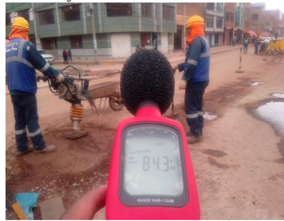
Figura 65: Monitoreo de ruido de la apisonadora
