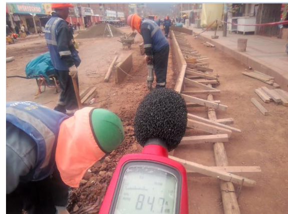
Figura 57: Monitoreo de ruido durante trabajos de excavación para sardinel en veredas
