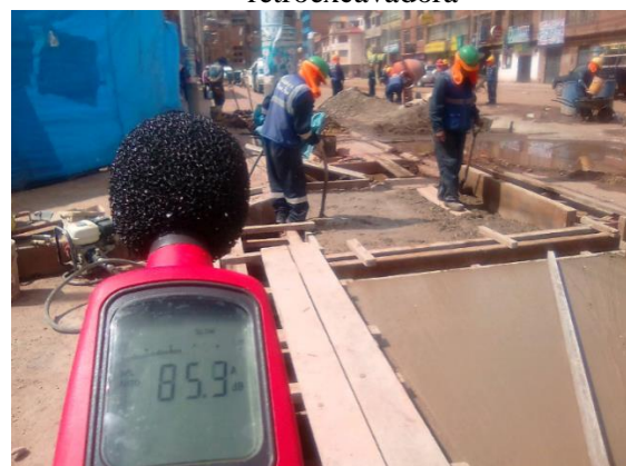
Figura 71: Monitoreo de ruido de vibradora de concreto
