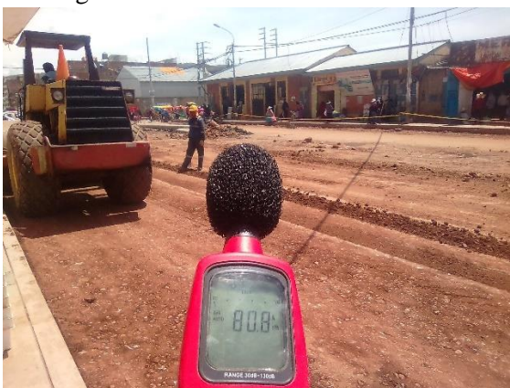
Figura 56: Monitoreo de ruido durante los trabajos de conformación de base granular
