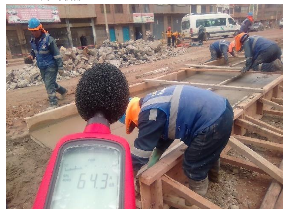
Figura 57: Monitoreo de ruido durante trabajos de excavación para sardinel en veredas
