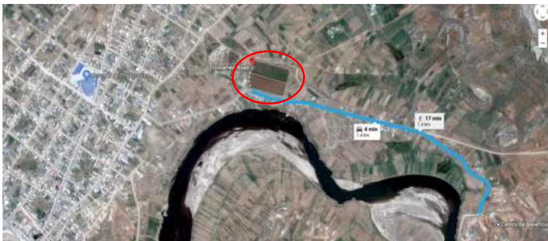
Figura 3. Vista de la planta de tratamiento de aguas servidas de la ciudad de Ilave
