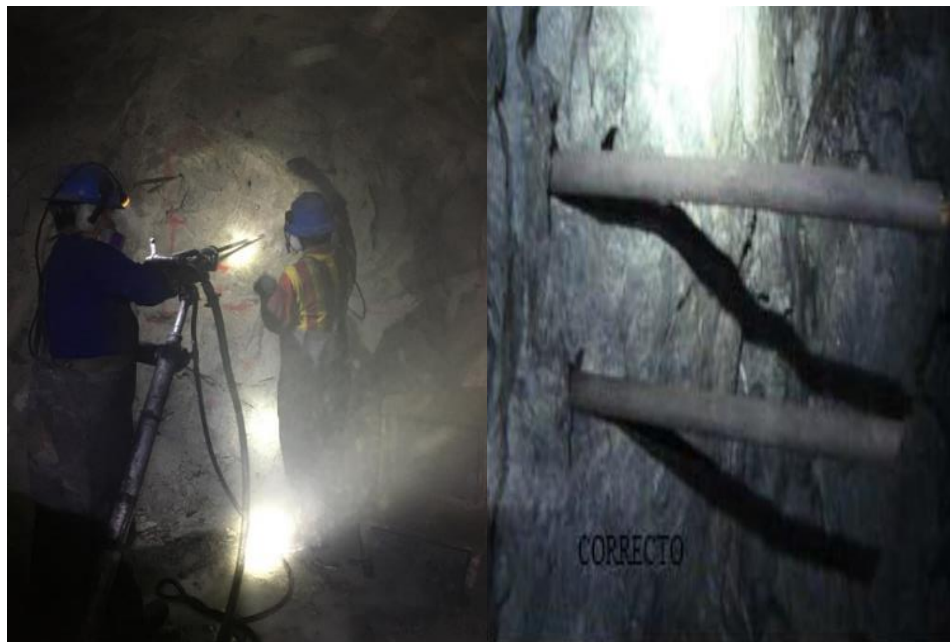
Figura 31. Uso de guidores para un mayor control de paralelismo en los taladros
