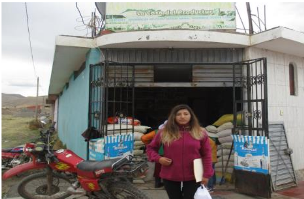
Figura 8: Comercialización de agroquímicos Fuente: Fotografía tomada en octubre del 2019
