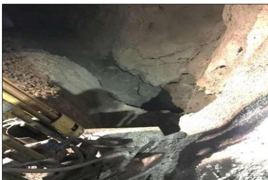
Figura 1. Vista de caja techo inestable TJ-75. Fuente: Elaboración propia
