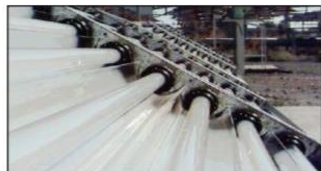
Figura D-4: Reflexión sobre reactor de fotocatalisis solar-Detalle de un colector.
