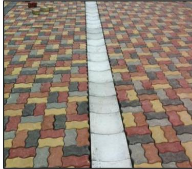
Figura N° 5: Pavimento adoquinado con drenaje pluvial longitudinal
