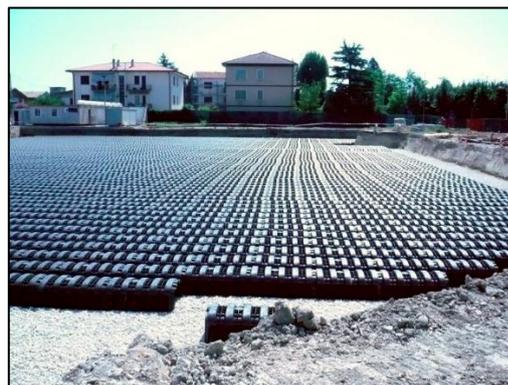
Figura N° 12: Depósito de detención
