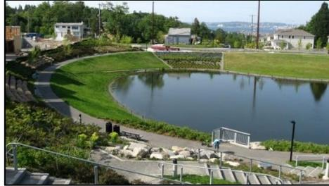
Figura N° 11: Depósito de detención
