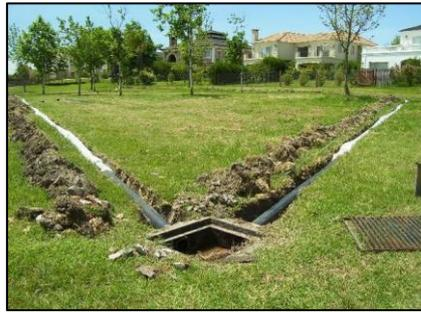
Figura N° 7: Zanja de infiltración en construcción
