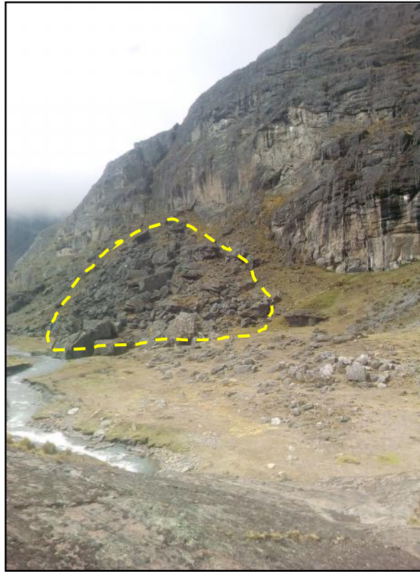
Figura N° 34: Depósito Coluviales, margen derecho del rio Occoruruni.
