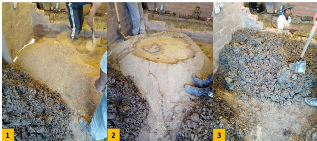
*Figura 16.* Proceso de mezclado.
