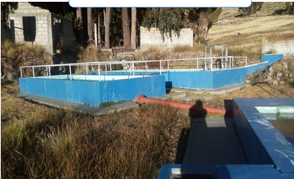
Planta de tratamiento: Choquechaca
