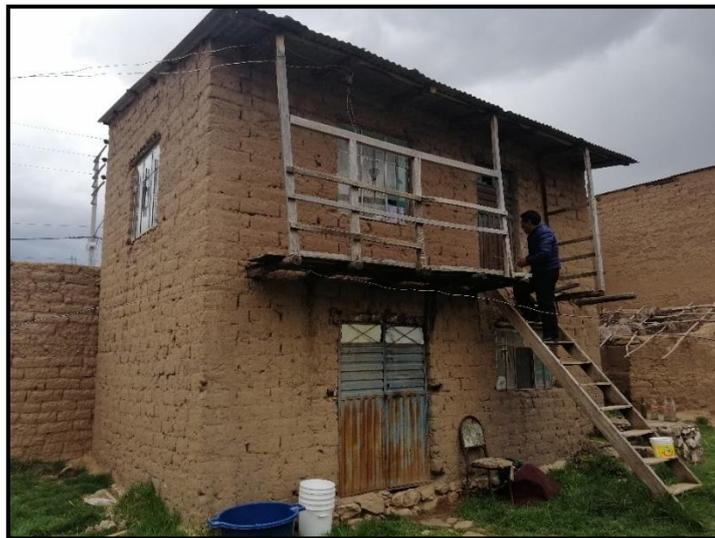
**Figura 24: Techo representativa a una sola agua (elaborado por el equipo de trabajo).**
