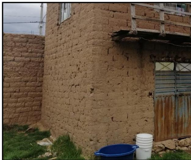
**Figura 20: Distribución del asentado de adobe de cabeza en muros (elaborado por el equipo de trabajo)**
