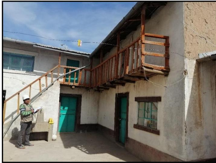
**Figura 22: Vista del espaciamiento de los rollizos en el entrepiso (elaborado por el equipo de trabajo).**
