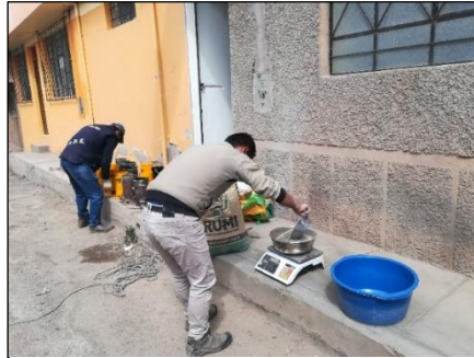
Figura 33: Dosificación del cemento Portland en peso.
