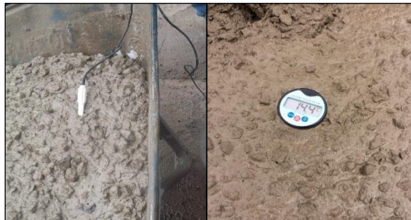
Figura 45: Verificación de la temperatura del concreto en campo.
