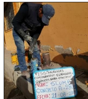
Figura 35: Verificación del asentamiento en el concreto.
