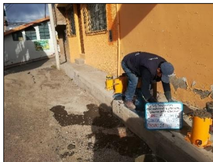
Figura 34: Toma de muestras de concreto fresco.
