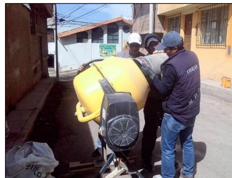
Figura 32: Suministro de agregados a la mezcladora de concreto.
