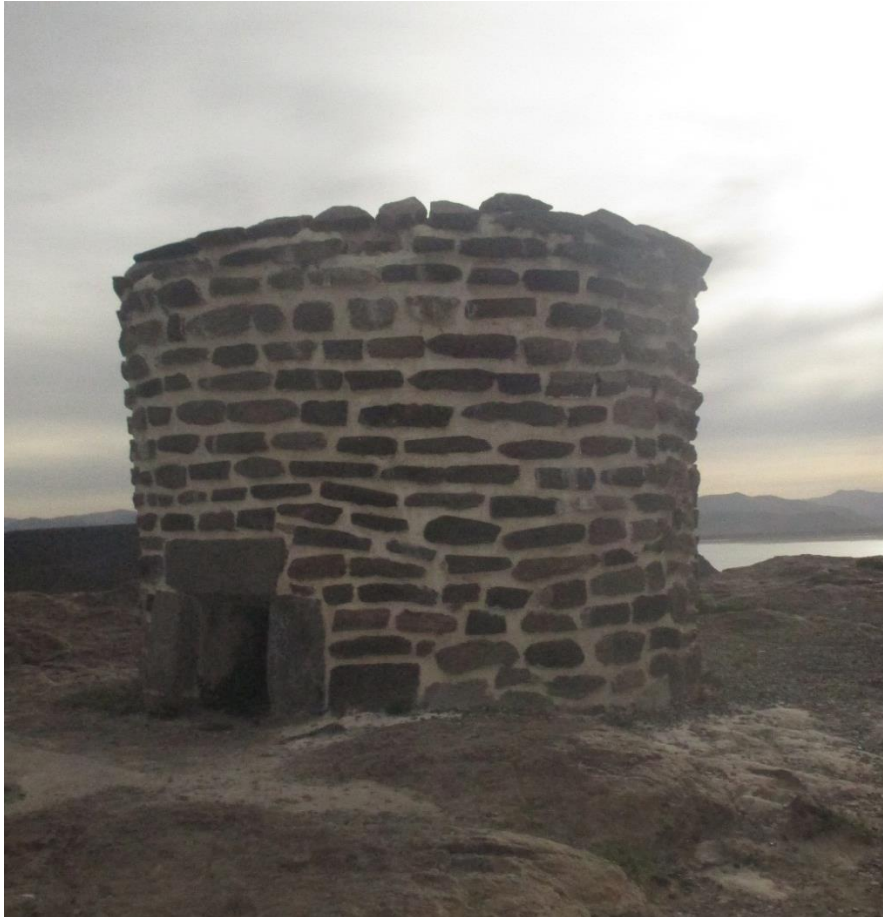
Figura 7. Chullpas de la época inca de mampostería mixta – Sillustani. Fuente: vista fotográfica (2018).
