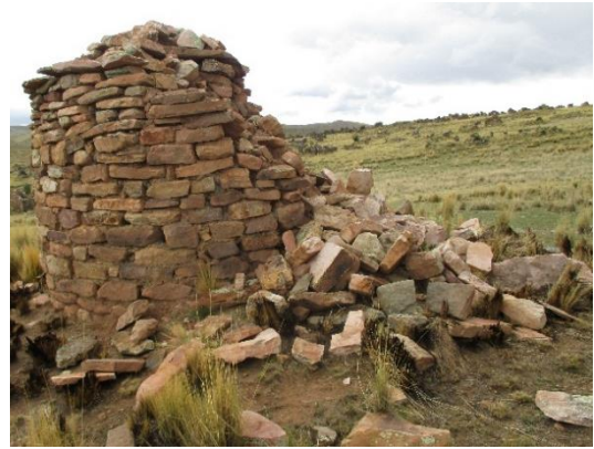
Figura 15. Chullpas de mampostería ordinaria simple – Mauka Llaqta.
