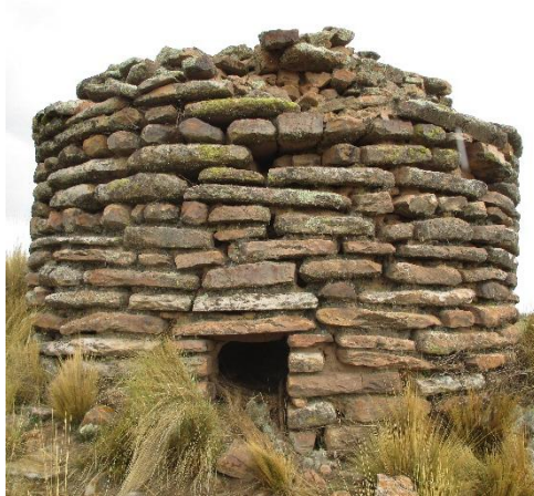
Figura 15. Chullpas de mampostería ordinaria simple – Mauka Llaqta.
