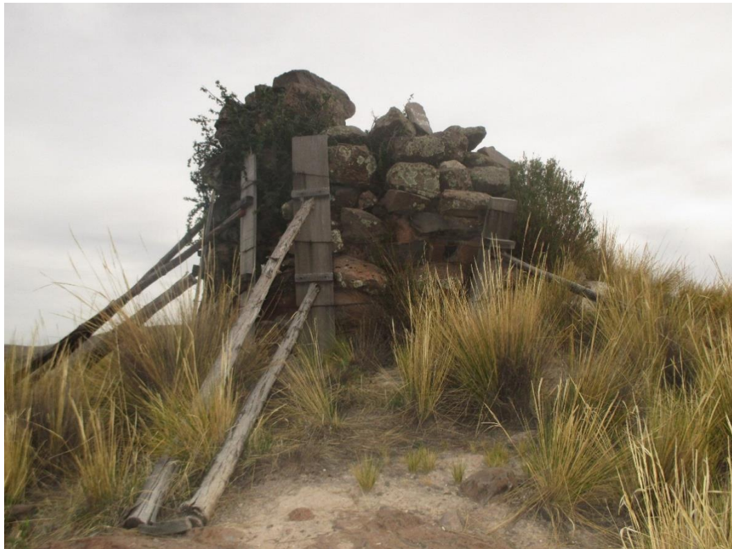
Figura 20. Estado actual de los chullparios de Hatuncolla Fuente: vista fotográfica (2018).
