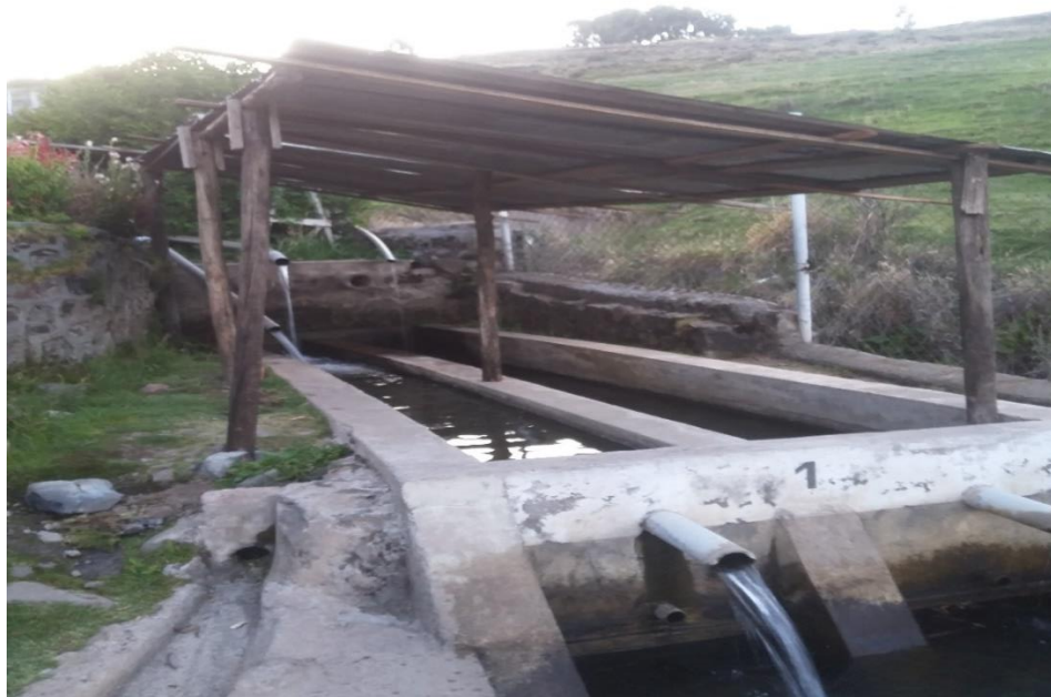
C.1 Imagen, construcción e implementación del área de ejecución del proyecto fotoperiodo.
