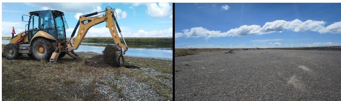
Figura N° 25. Cantera rio callata Paconcani (Agregado).
