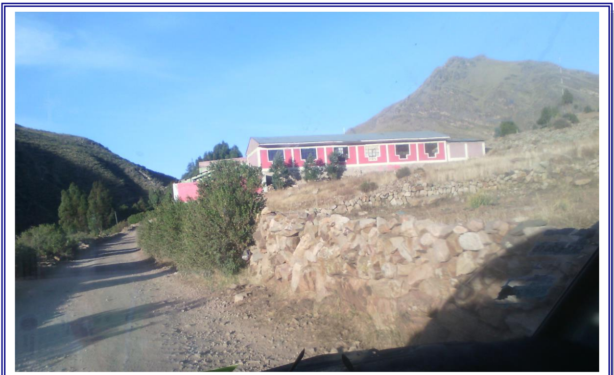
Foto N°2 IE Antonio Raymondi ubicado en la localidad de Oyo-oyo
