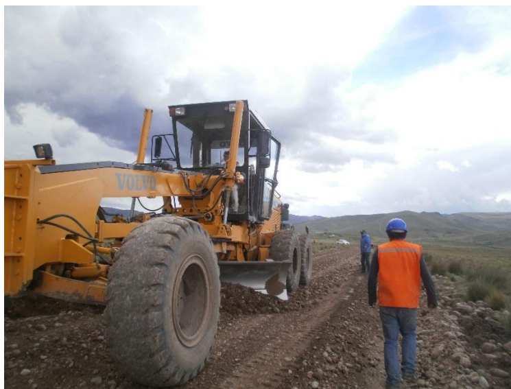
Figura 1: Explanación de la vía.
