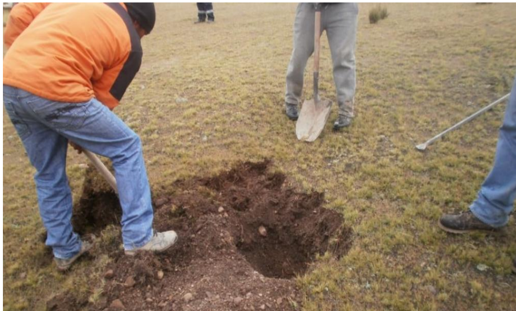
Fotografía 6: En la imagen se observa la excavación de calicata en la cantera N° 1 en las coordenadas N 8374292, E 232822.
