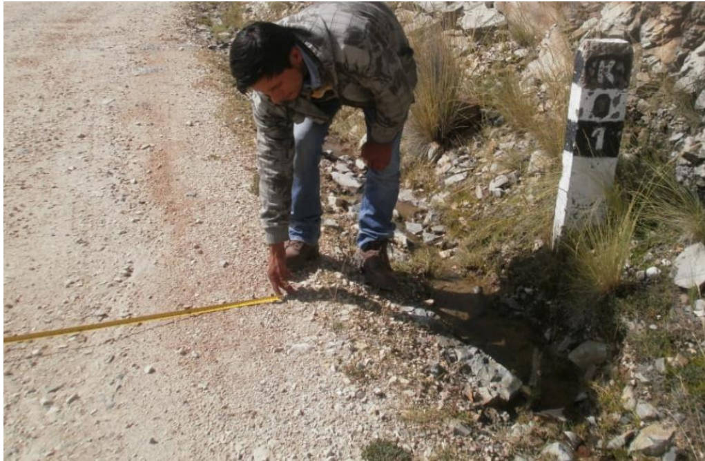
Fotografía 1: Se realiza los trabajos preliminares de topografía y verificación de espesor de la plataforma existente en la progresiva 1+000.
