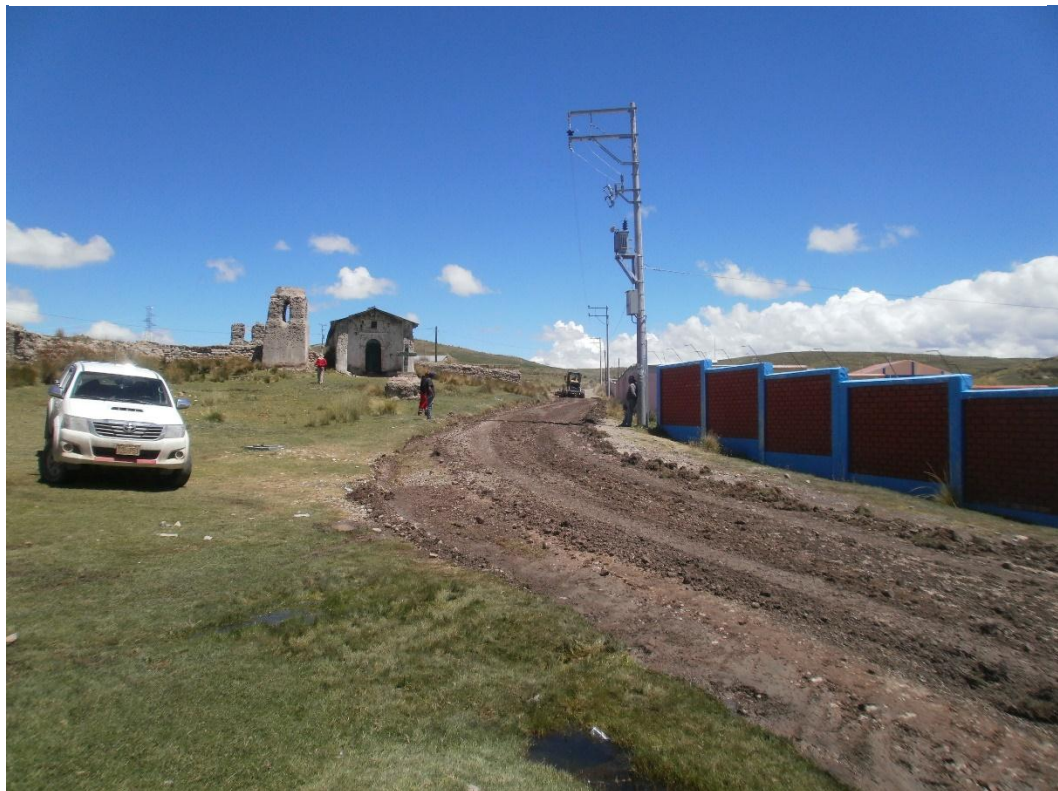
Fotografía 8: En la imagen se aprecia el escarificado de la capa actual de la plataforma existente en la progresiva 16+000.
