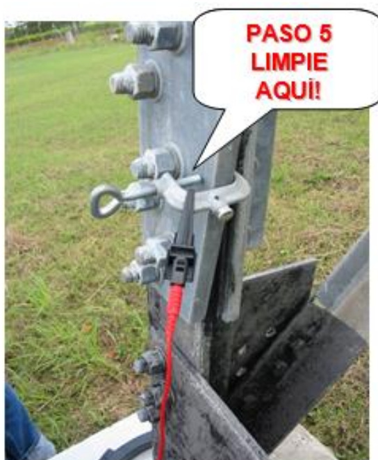
Figura N° 4.5: Colocación del caimán o prensa.
