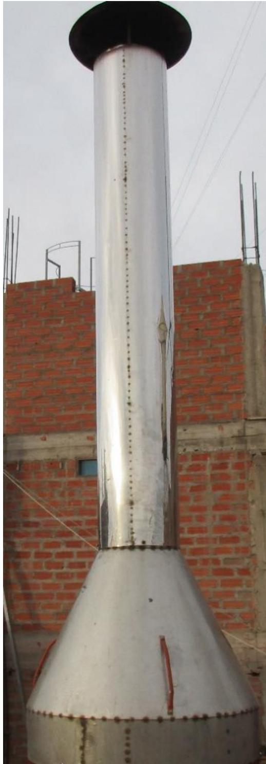
Figura N.º 3.13: Chimenea
