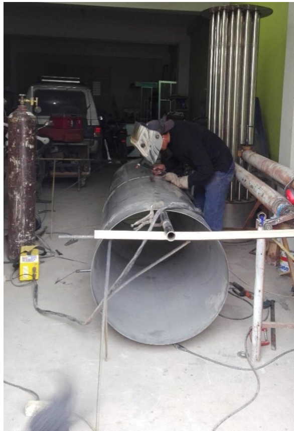
Figura N.º 3.12: Trabajo en soldadura del cuerpo cilíndrico del caldero
