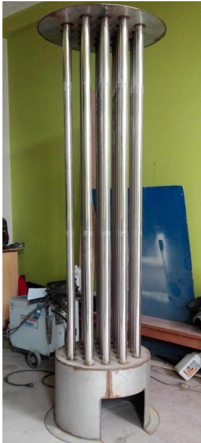
Figura N.º 3.11: Interior del caldero antes de soldar el cuerpo cilíndrico
