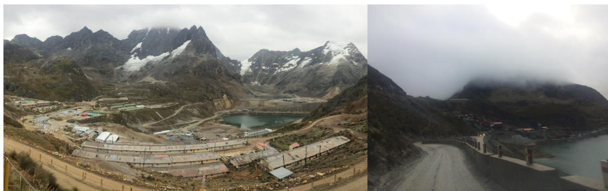
Figura 2: Izq. Campamento de la Mina Raura; Der. Planta concentradora - 2019
