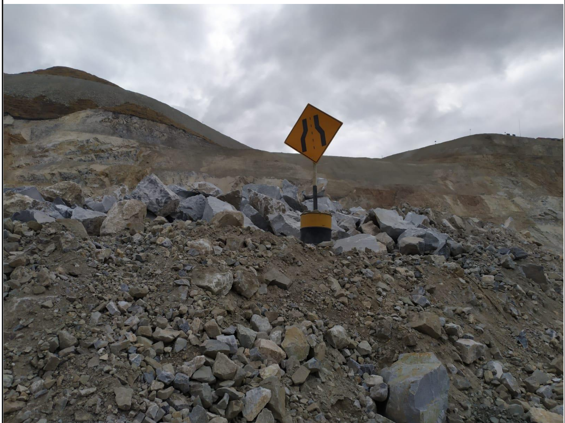
Figura 8. Antes y después de instalacion de letrero reduccion de via – tramo 4.
