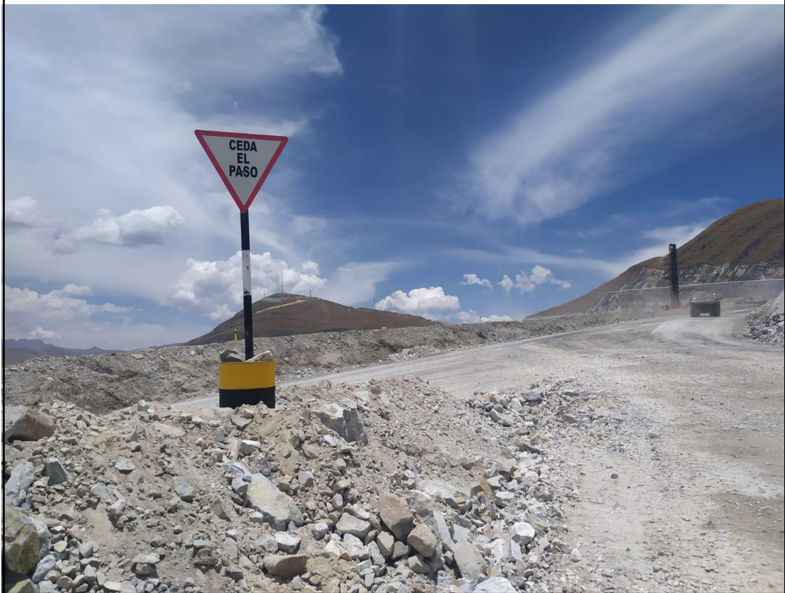
Figura 7. Antes y después de instalacion de letrero ceda el paso – tramo 6.
