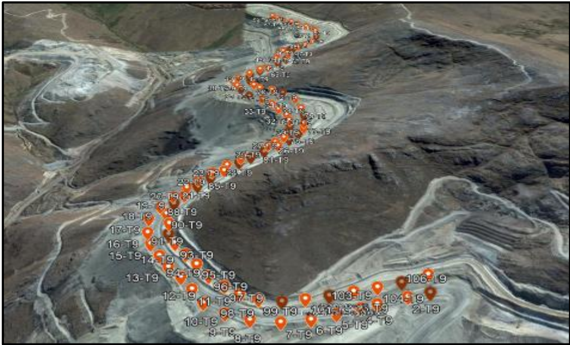
Figura 7: Ubicación de delineadores en tramo 9
