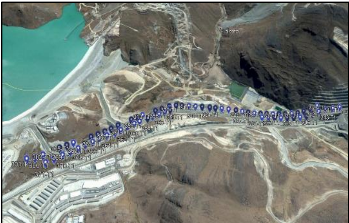
Figura 2: Ubicación de delineadores en tramo 1.
