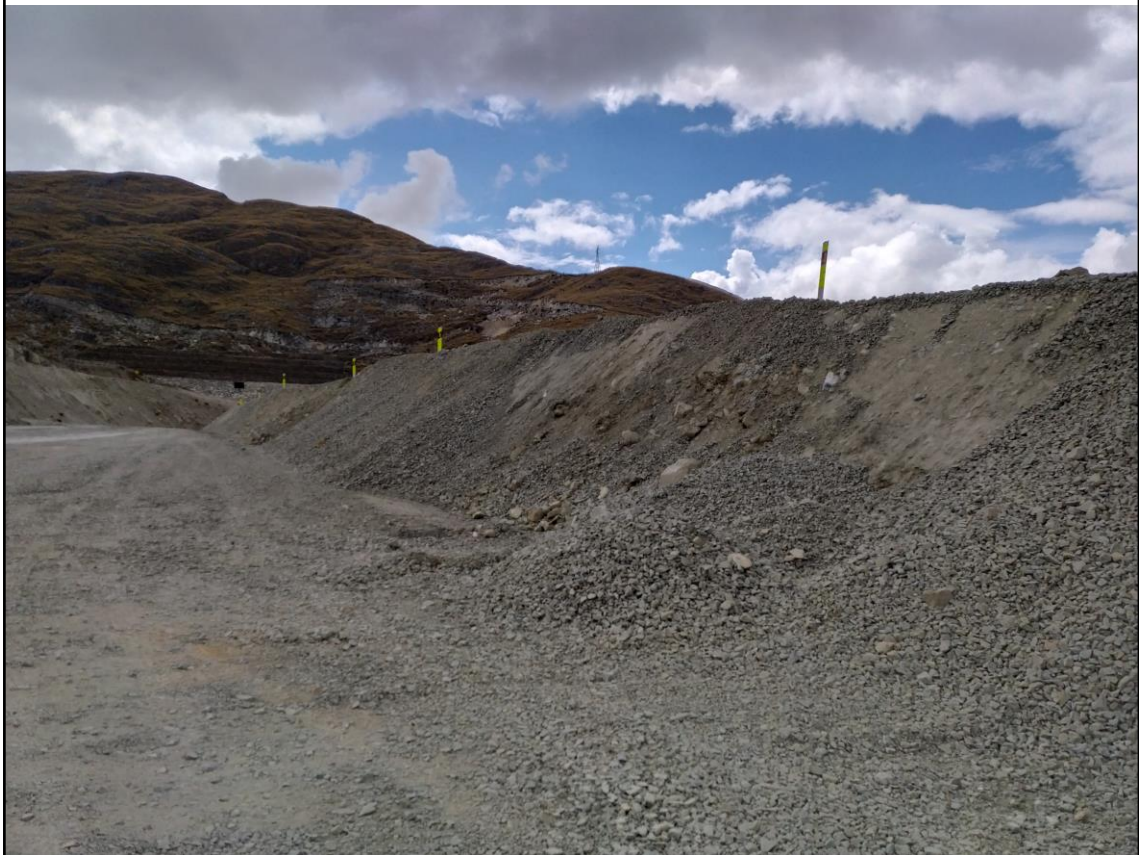
Figura 1: Antes y después de instalación de delineadores - tramo 5.
