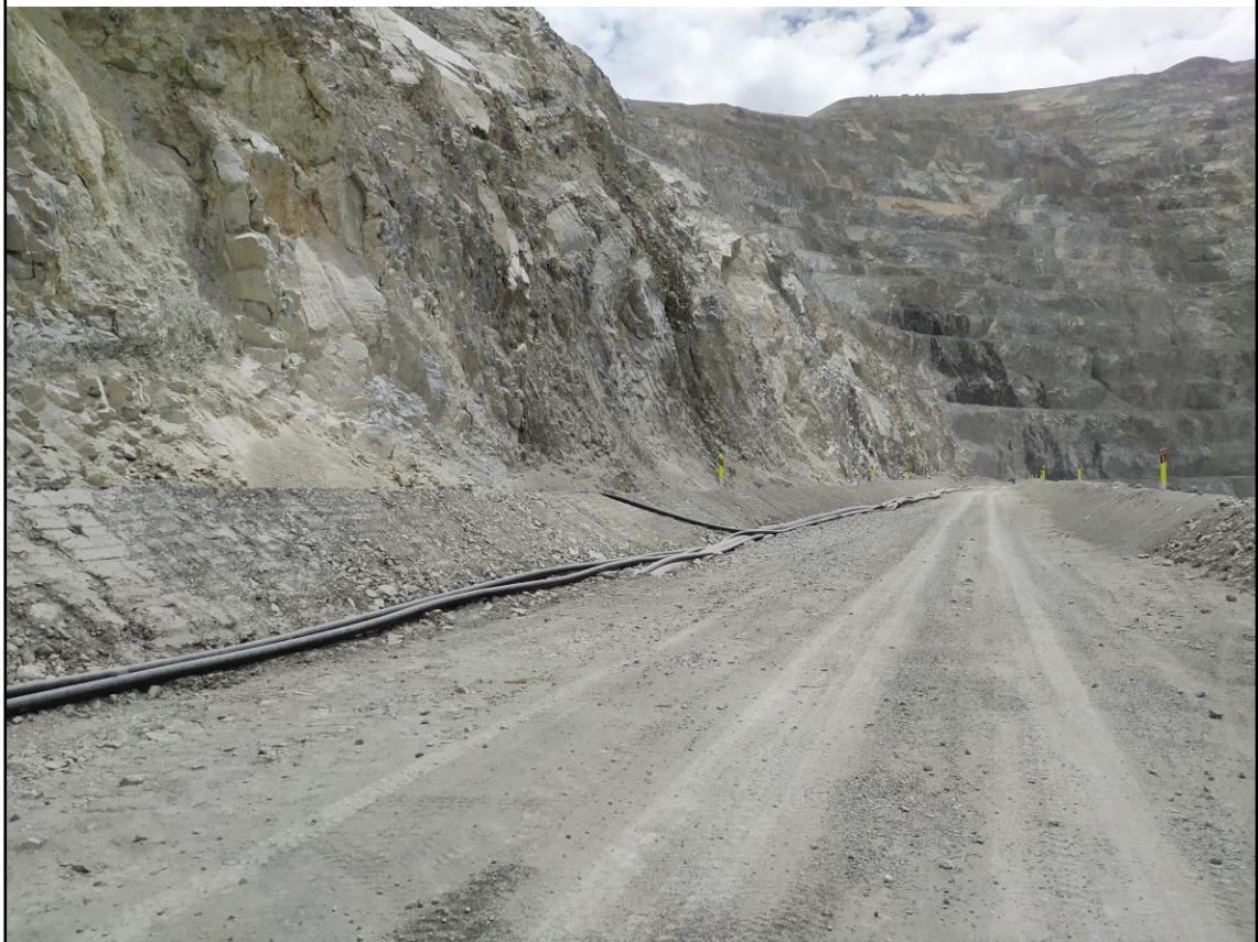
Figura 2. Antes y después de instalación de delineadores - sumidero 10.
