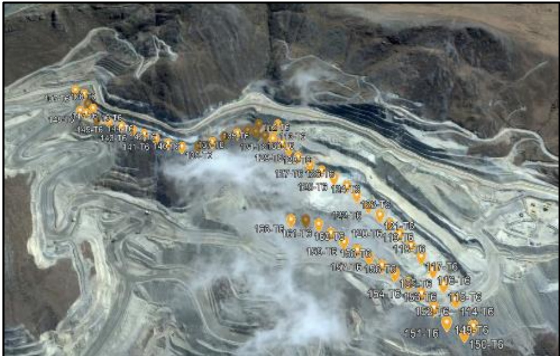
Figura 6: Ubicación de delineadores en tramo 6
