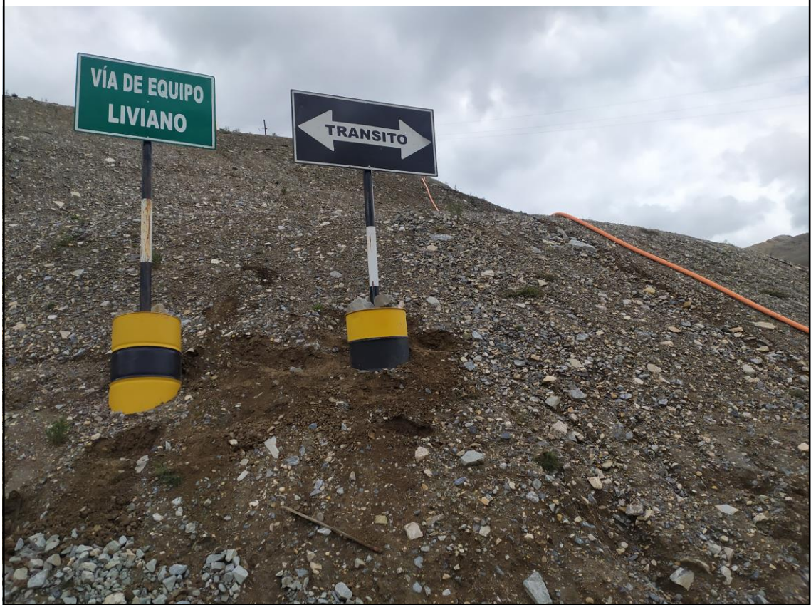
Figura 2. Cambio de letrero a vía de doble sentido – tramo 0.
