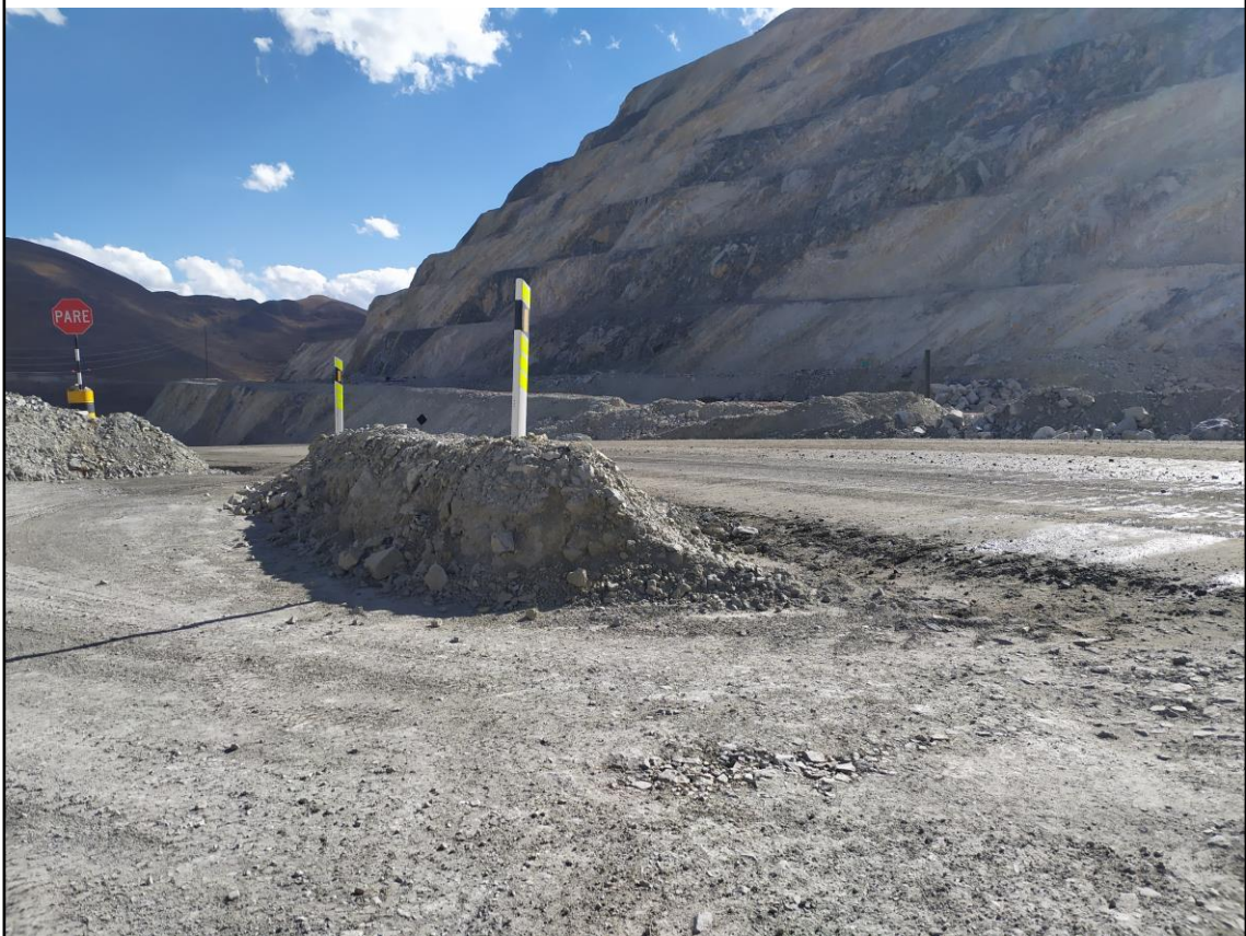
Figura 3. Antes y después de instalación de delineadores en refugio - tramo 4.
