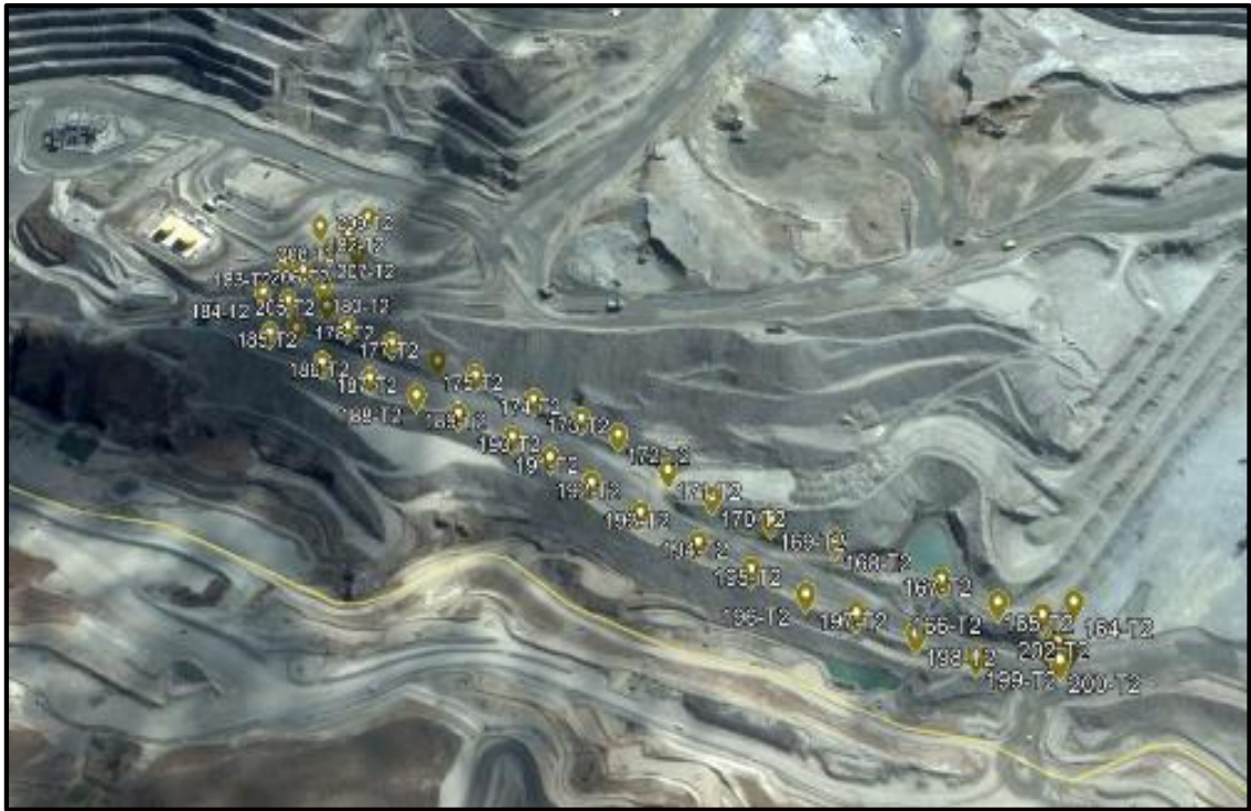
Figura 3: Ubicación de delineadores en tramo 2
