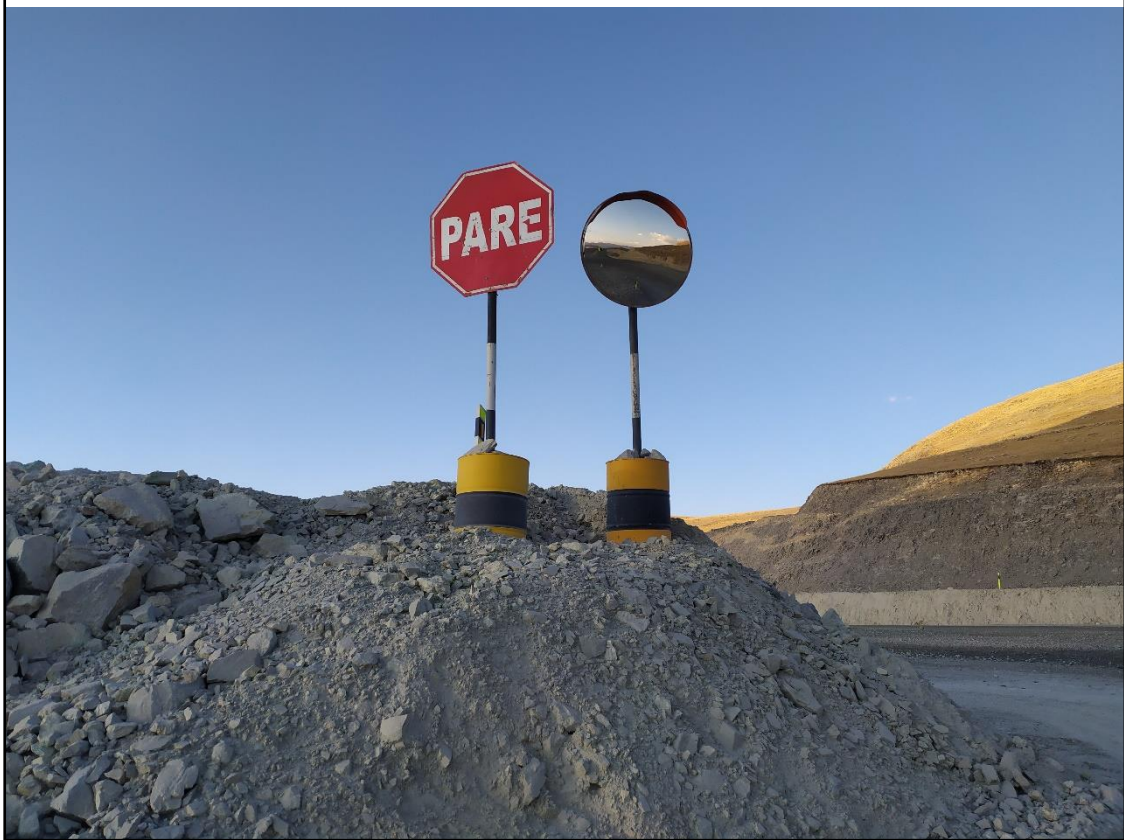
Figura 1: Antes y después de la instalación de 01 espejo – tramo 9.
