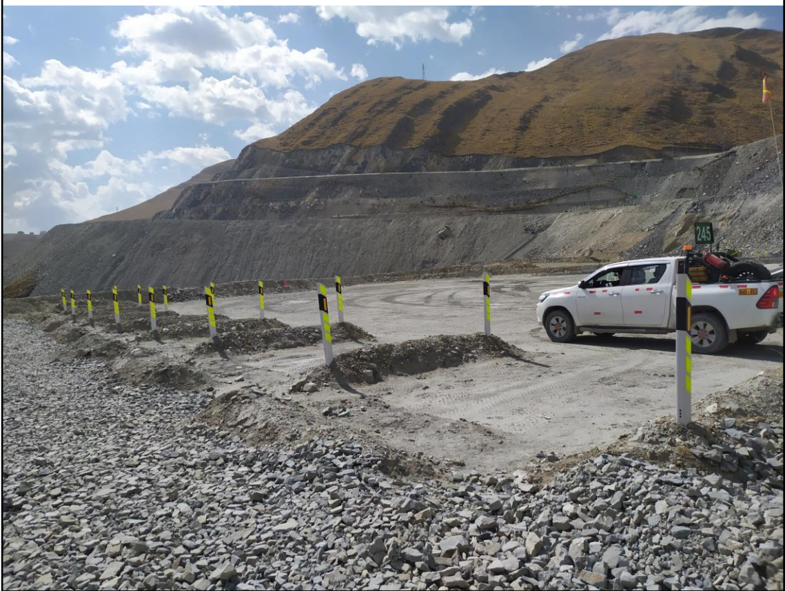
Figura 5. Antes y después de instalación de delineadores mirador Pierina – tramo 6.
