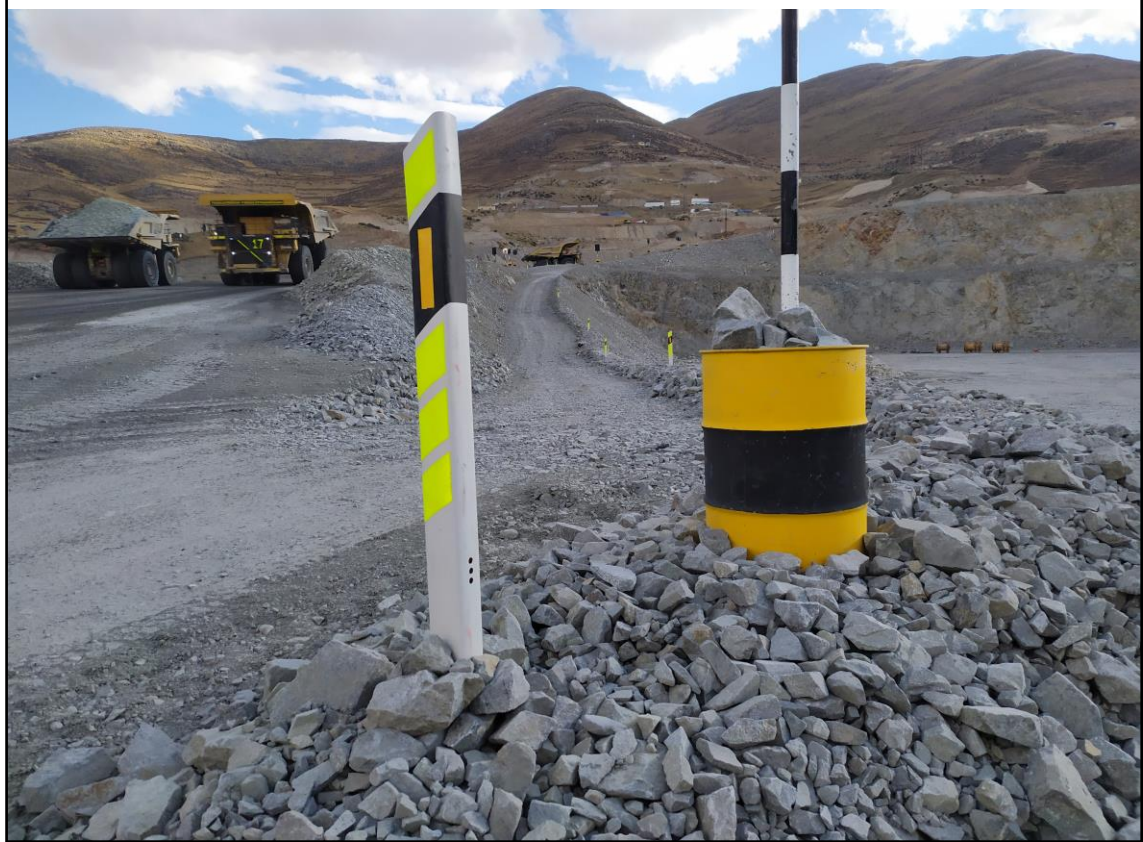
Figura 4. Antes y después de instalación de delineadores vía auxiliar – tramo 2.
