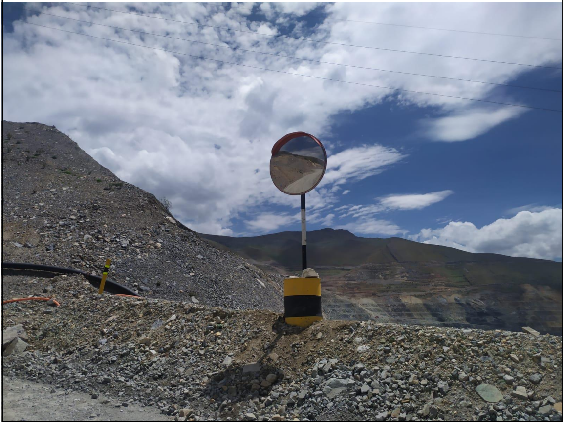
Figura 6. Antes y después de instalacion de espejo – tramo 3
