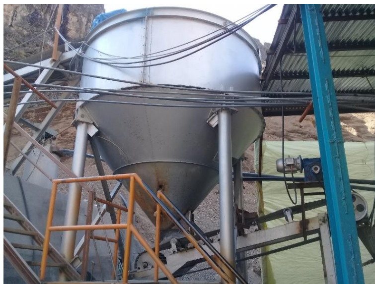
Figura N° 25: Se observa la tolva de finos y la faja N° 2 del Circuito de Molienda de la Planta San Carlos.
