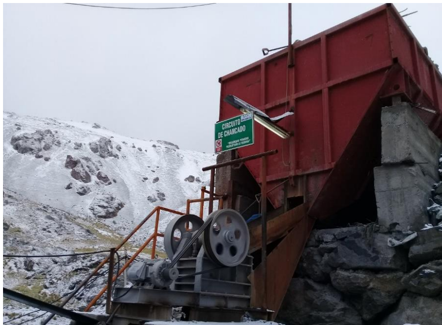
Figura N° 18: Se observa la tolva de gruesos del circuito de Chancado de la Planta San Carlos.
