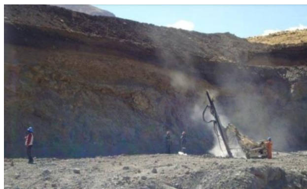
Figura 8: Perforadora Track Drill en operación
