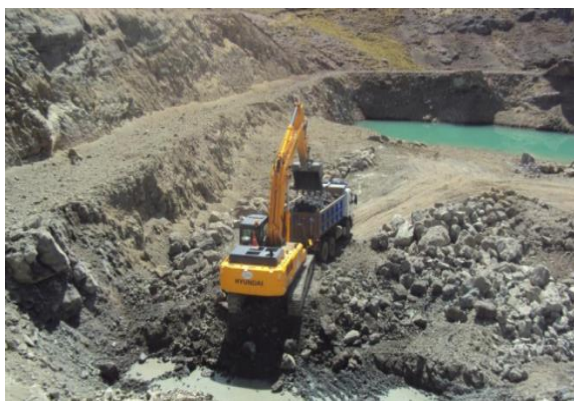
Figura 5: Excavadora hidráulica Fuente: Unidad Minera Tacaza-CIEMSA
