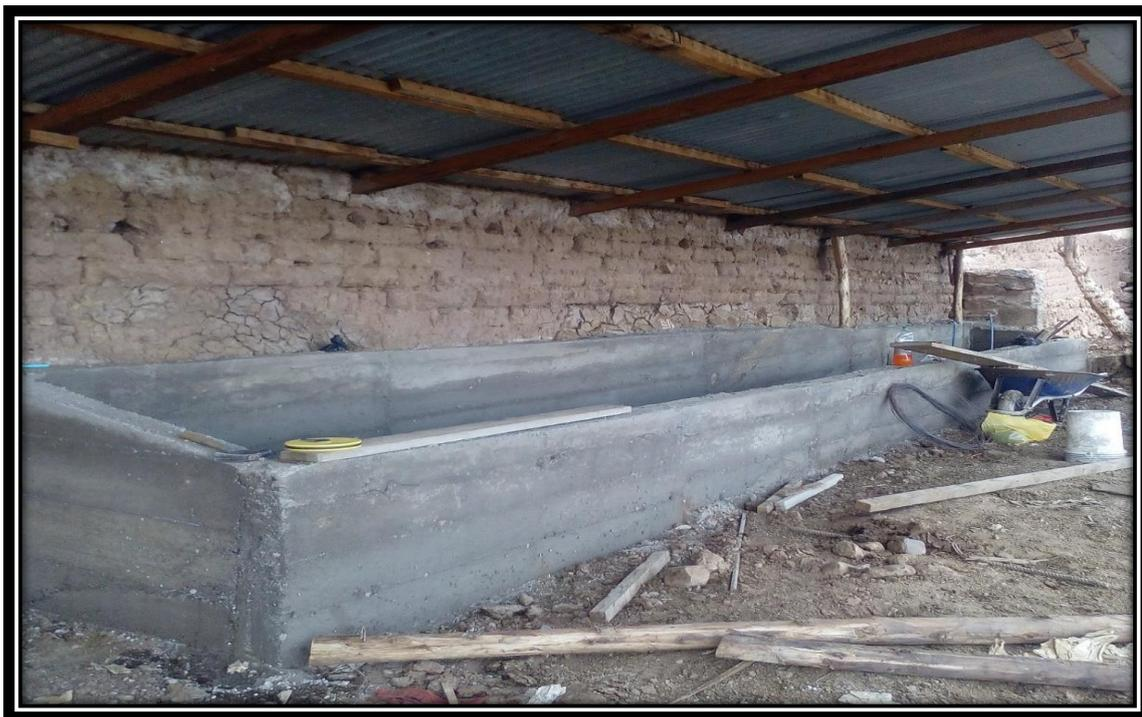
**Figura 18.** Desencofrado del comedero y bebedero en el CE – Illpa - UNAP.
