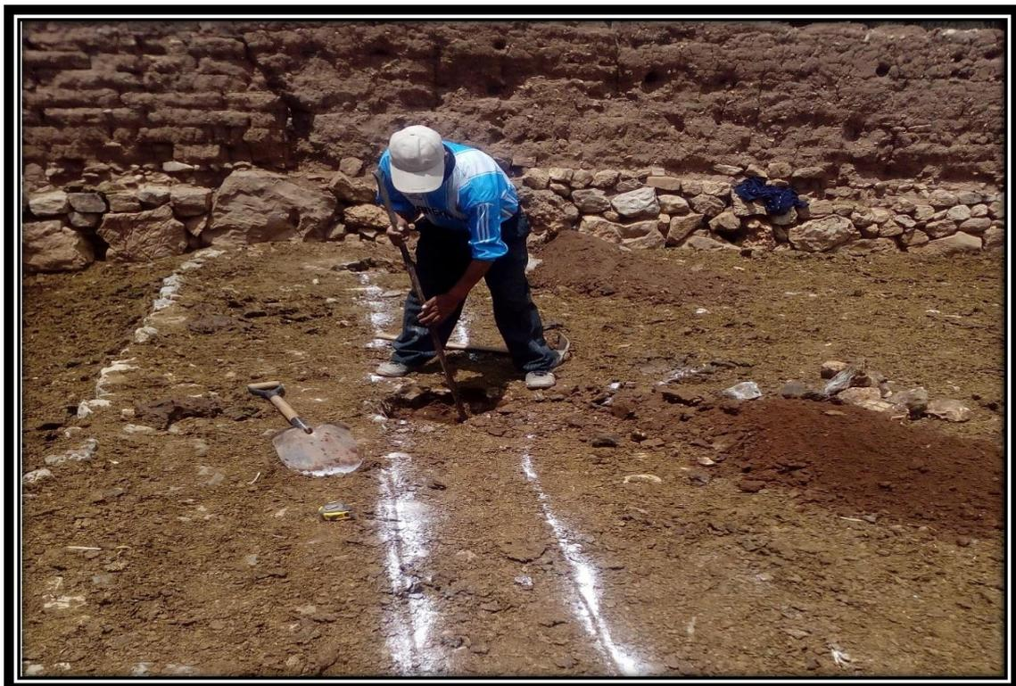
**Figura 14.** Trazo para la construcción del establo en el CE - Illpa - UNAP.
