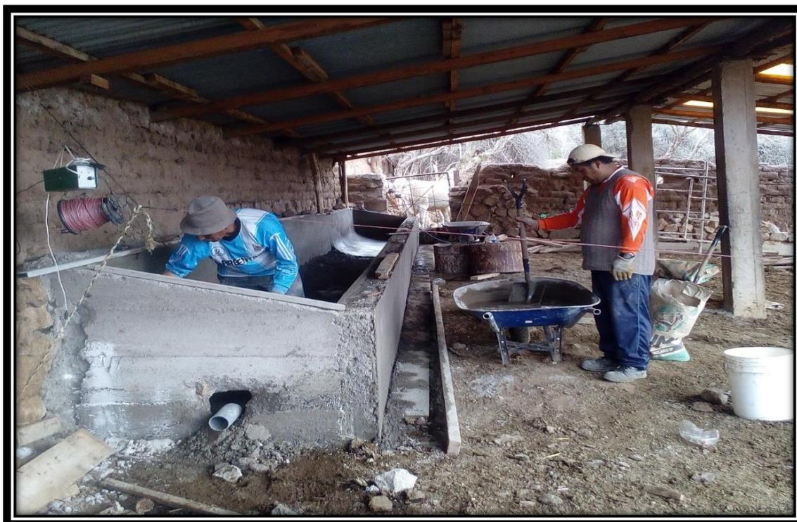
**Figura 19.** Revestimiento de la construcción del establo, comedero y bebedero en el CE – Illpa - UNAP.
